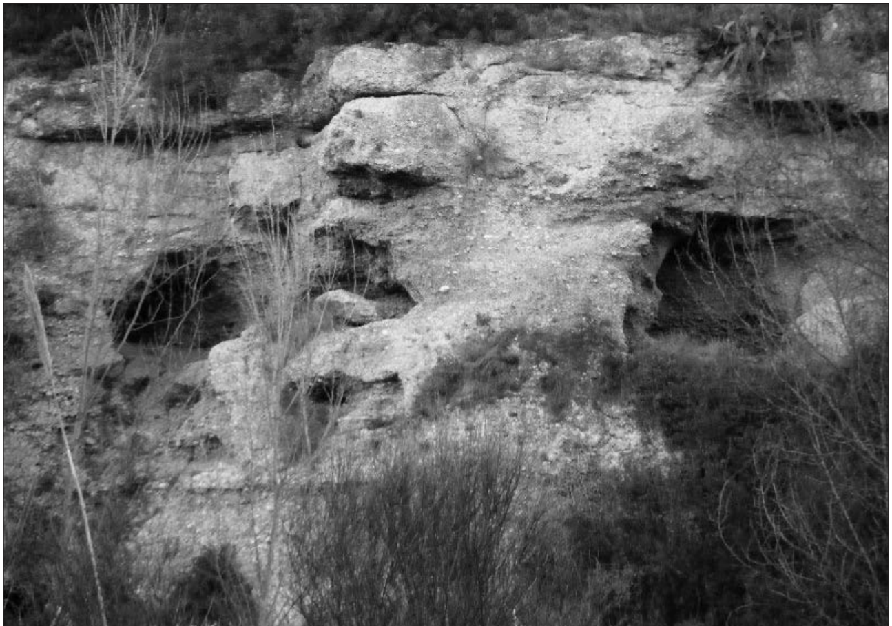
Figura 5.14. Detalle de los conglomerados cementados en arcilla, propios de La Plana y de la base de Villa Filomena y de los covachos característicos de los márgenes encajados del Millars.
