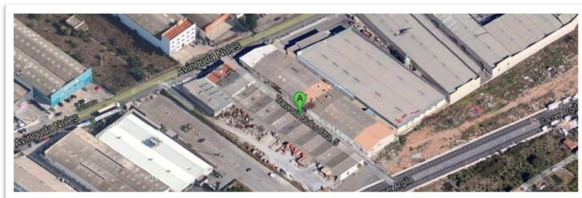
Figura 19. Localización de la nave objeto de estudio (Punto A). Travesía carretera de Nules 7.
