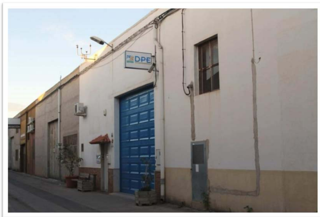
Figura 20. Fachada principal de la nave industrial objeto de estudio del TFM.
