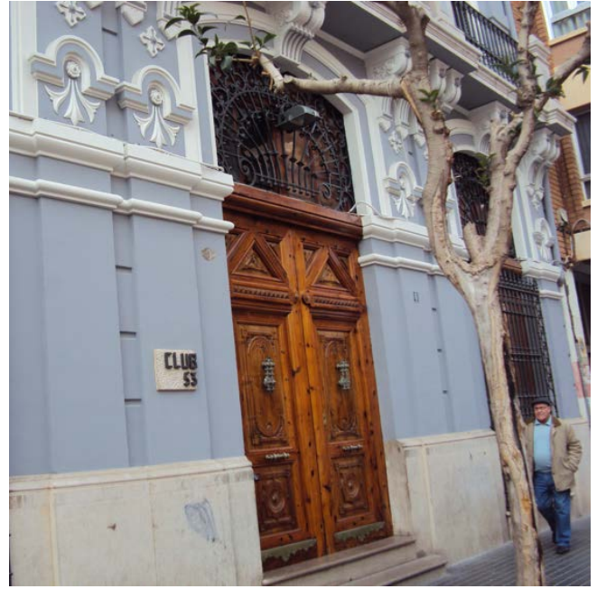
Figura 3. Ejemplo de arcos escarzanos. Plaza del cardenal Tarancón
