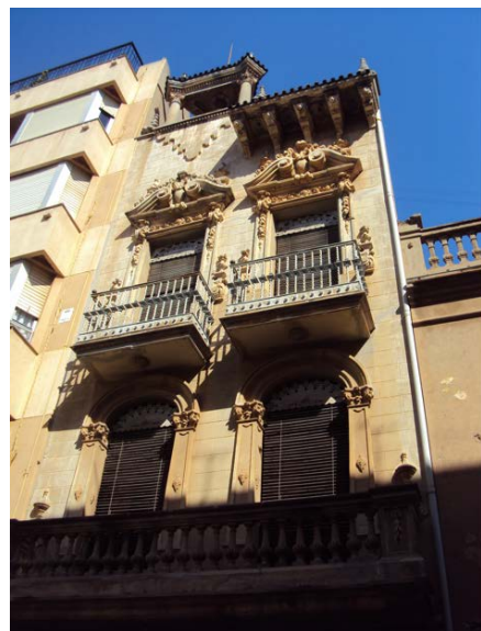
Figura 25. Casa Boix. Calle Mayor
