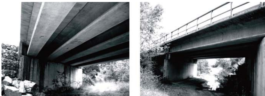
Figura 3. Imágenes del puente Arroyo Bracea II
