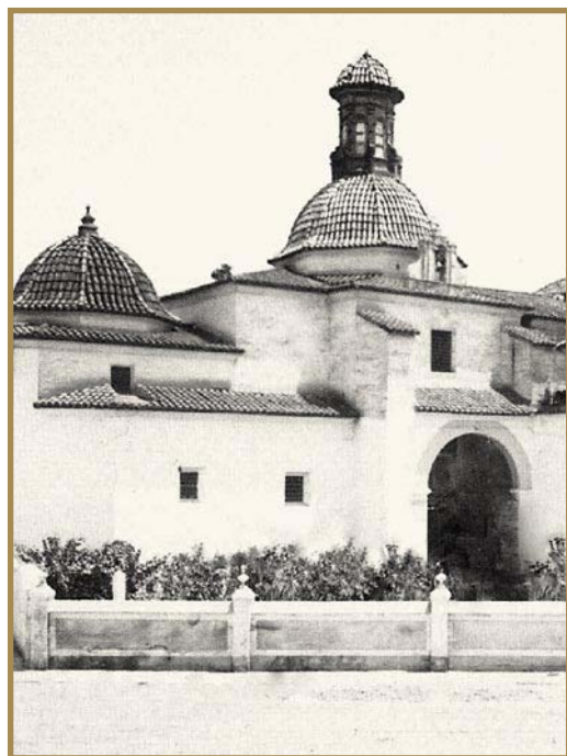
Exterior de la Real Capilla.
