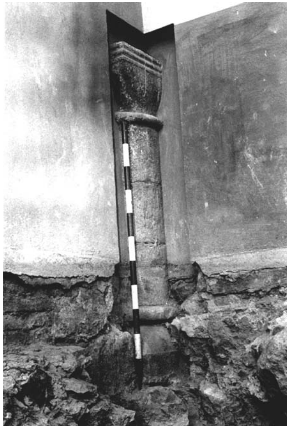
1. Columna empotrada de época medieval incierta, entre la fachada de la basílica y la casa abacial (foto SIAP).
