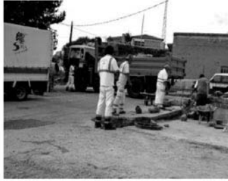
Julio/2010 – Ejecución de las obras
