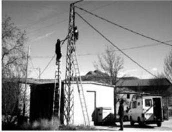
Marzo/2010 – Inicio obra: Fuentes de S. Pascual
