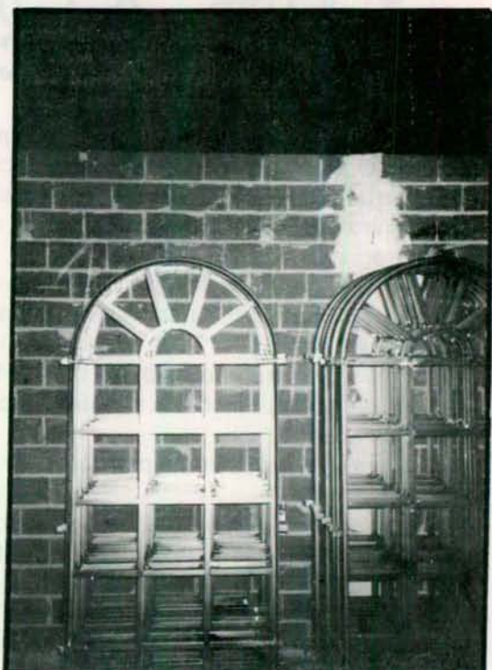
MARCO DE LOS 22 VENTANALES QUE IRÁN COLOCADOS EN LAS 22 VENTAS DE LOS PEQUEÑOS ABSIDES DEL CAMARIN.
