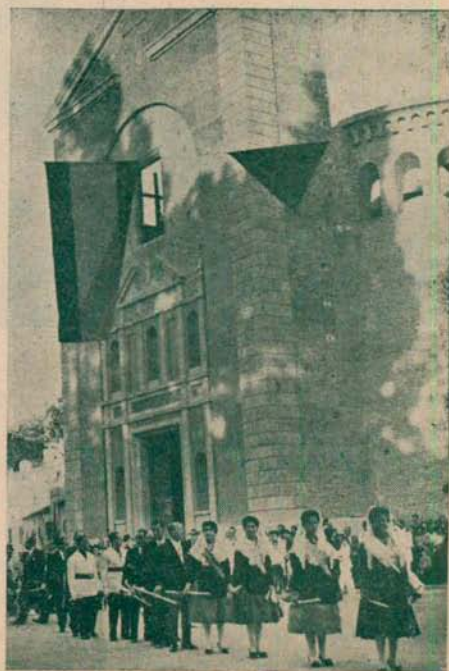
La procesión a su paso por San Pascual. En el fondo la nueva fachada terminada.
