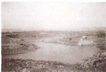
Fig. 3.—La Rambla de la Vinca en el Saloni. Vista, aguas arriba, del embalse del pantano. Sedimentos de superficie, continuación morfológica de la Plana
