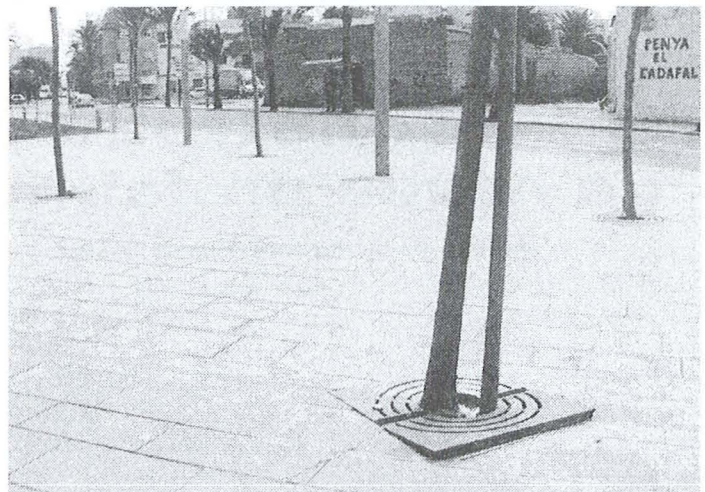
Els arbres no estan encaixats i hi han desnivells alarmants
