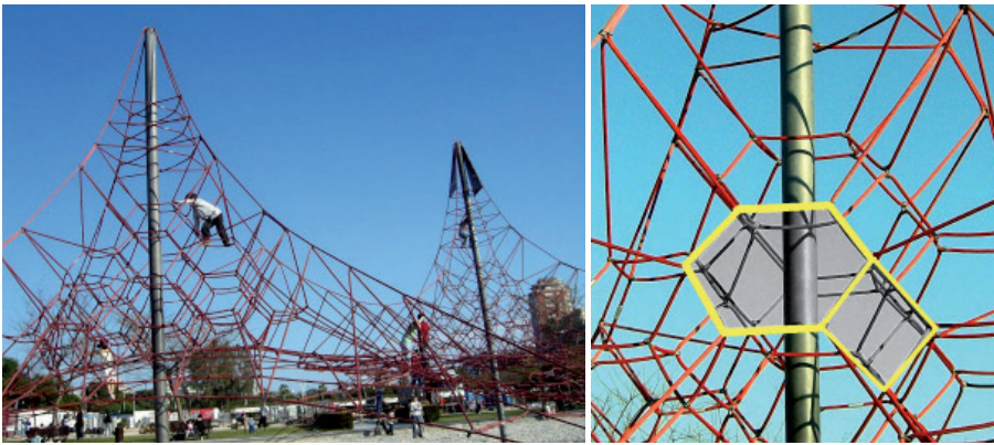
Fig. 85. En este juego de parque infantil se aplican las redes espaciales basadas en el octaedro truncado.
