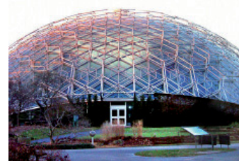
Fig. 102. Mackey y Murphy proyectaron el Climatron (1960), un ejemplo de aplicación de las redes modulares en la arquitectura.
