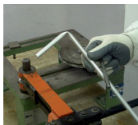
Fig. 385. Los tubos no resisten curvaturas pequeñas.
