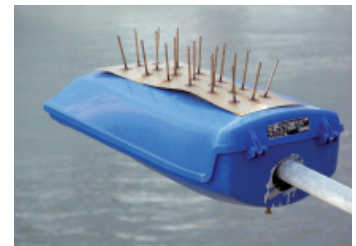
Fig. 233. Farola con un añadido posterior para evitar que las gaviotas y otras aves se apoyen.
