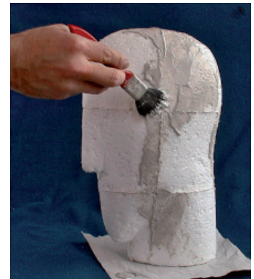
Fig. 516. Aplicación de la masilla niveladora con brocha. Se aprecian las irregularidades producidas por el pegamento en las juntas.
