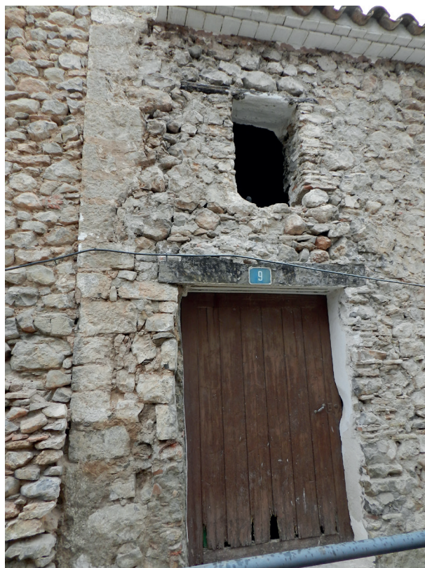
Figura 12. Cantonada de carreus del baluard de la muralla.
