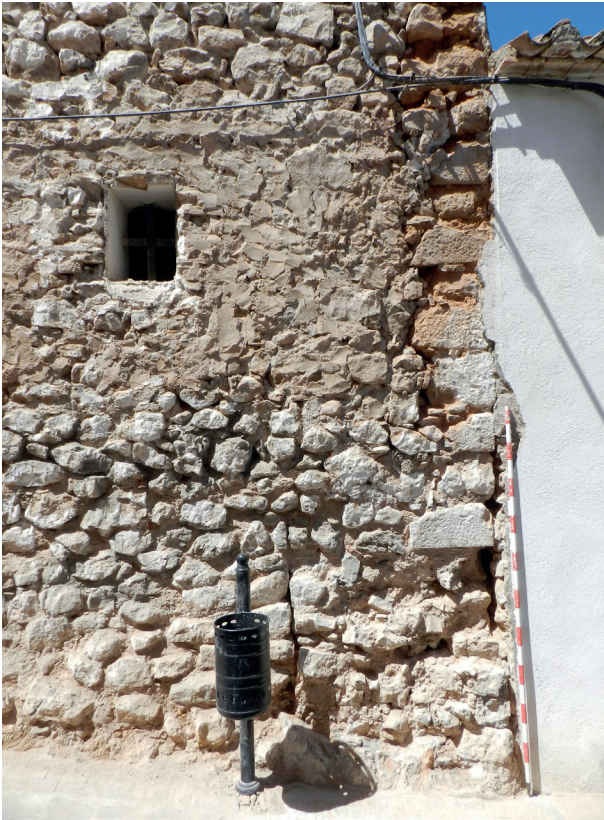
Figura 16. Detall d'una cantonera original de l'Hospital construïda sobre la muralla.
