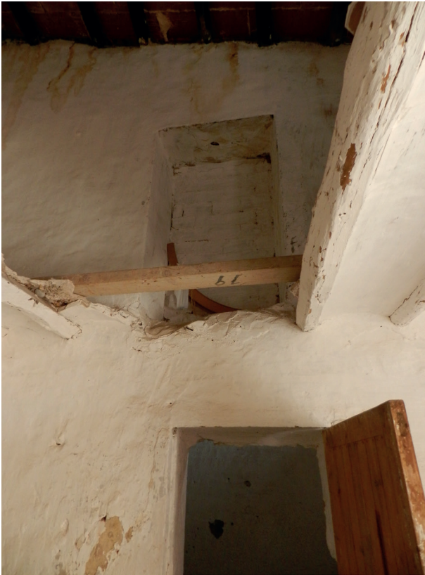
Figura 4. Vista interior de l'immoble abans de l'excavació.
