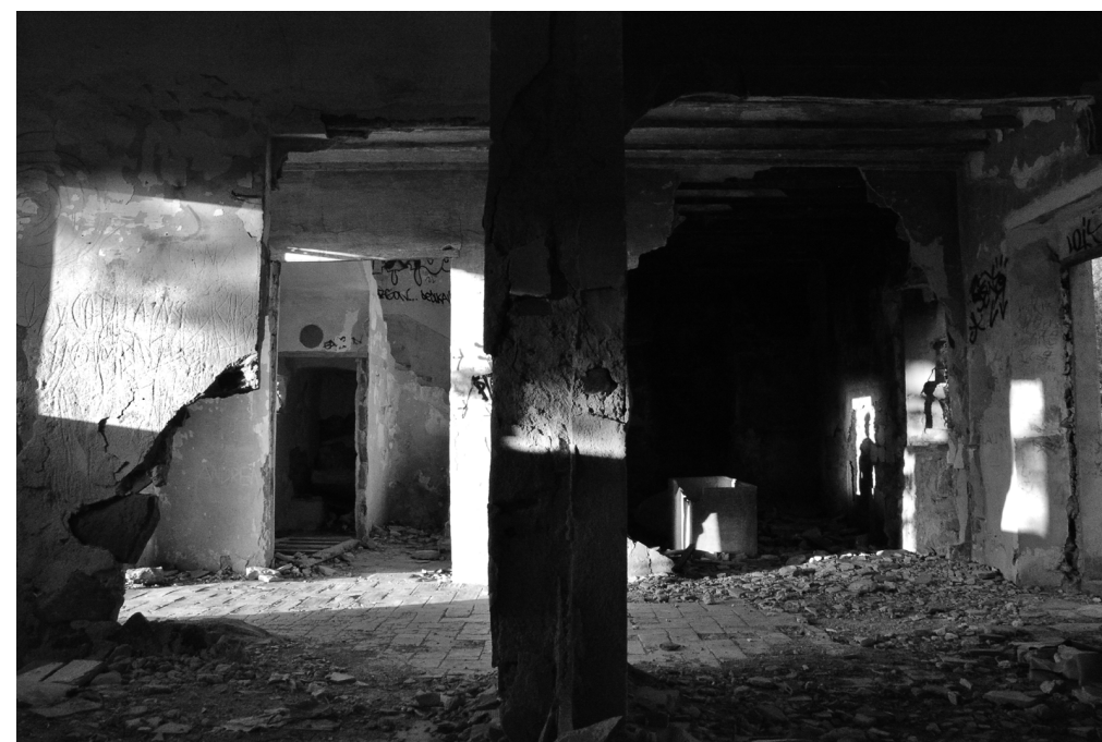
Fig. 16. Autora. (2023). Patrimonio o ruina . Fotoensayo compuesto por dos fotografías de la autora (2026). Arriba, despoblado de Jinquer (Castellón). Abajo, interior de La Mosquera, Almedijar (Castellón), masía que sirvió para los trabajos de extracción del corcho en el siglo XIX.
