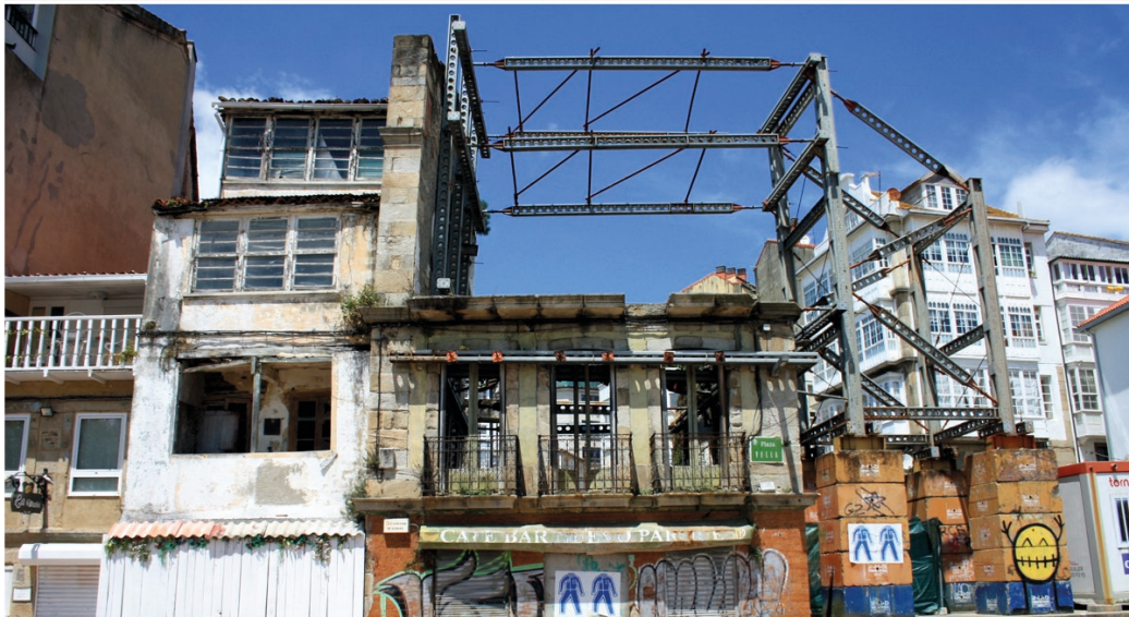
Figura 8.4. Estabilizador de un edificio en Ferrol. Autor: Juan Oliver García
