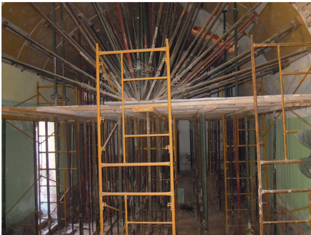
Figura 8.5. Apeo en el palacio de Betxí
