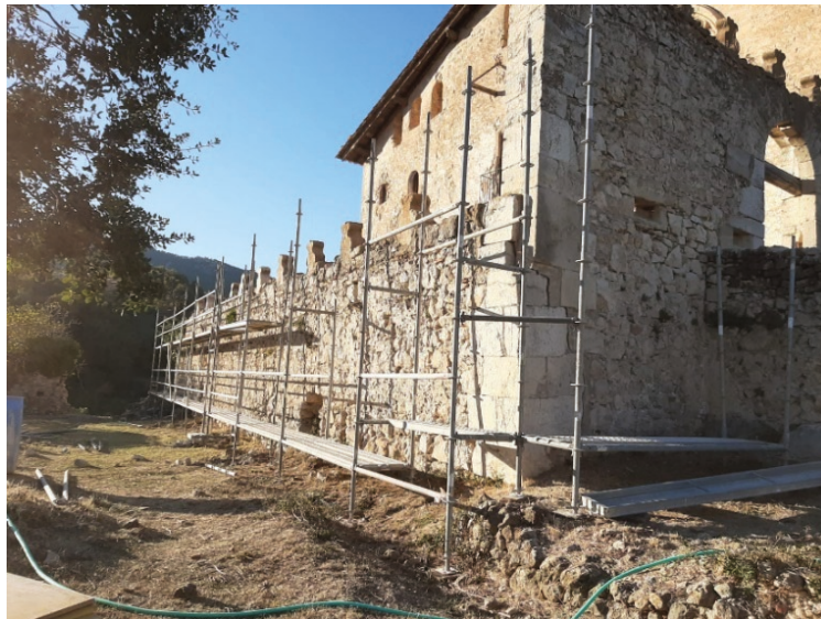
Figura 6.3. Andamio en Herbers
