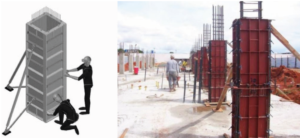
Figura 7.1. Encofrado de pilares. Fuente: encofrados.org
