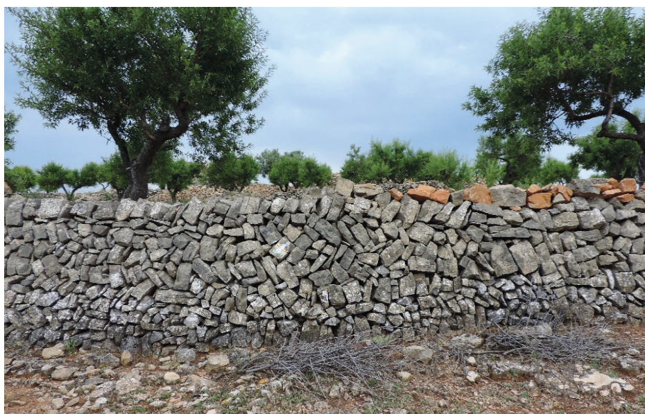
Figura 1.1. Muro de piedra en seco en Atzeneta del Maestrat
