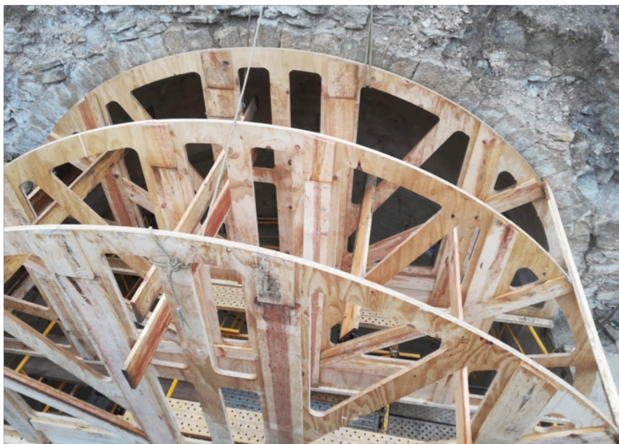
Figura 8.1. Cimbra de una bóveda en la aldea de Saranyana
