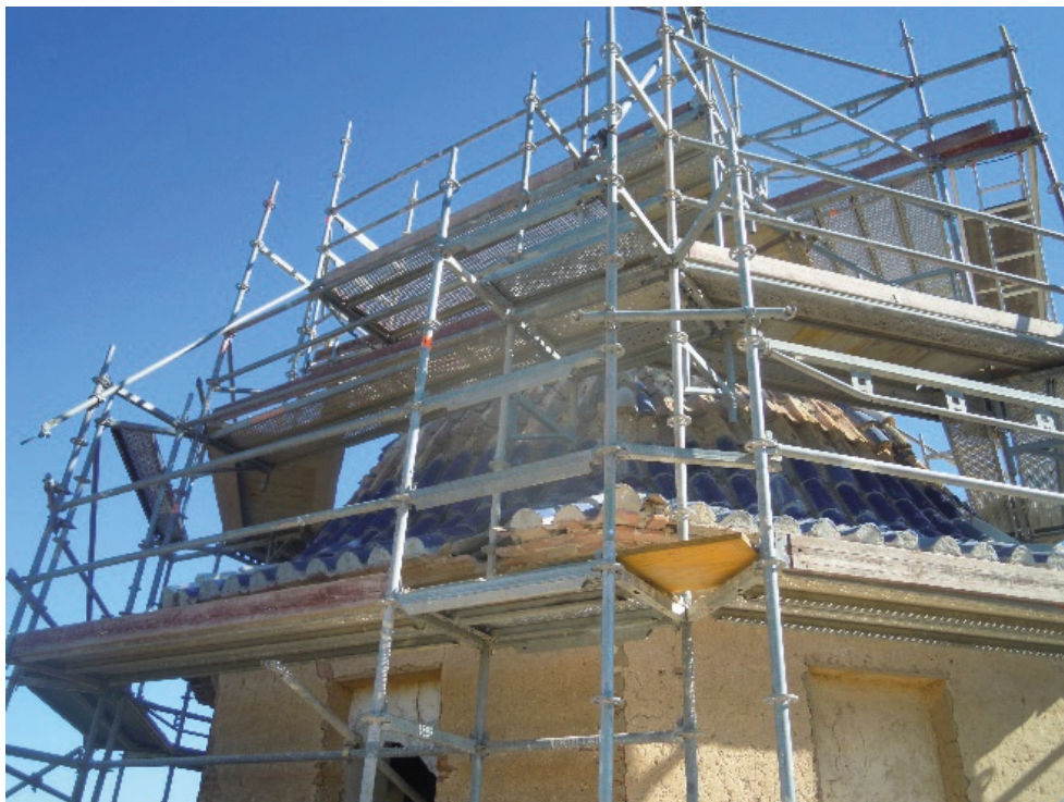
Figura 6.2 Andamio en Canet lo Roig
