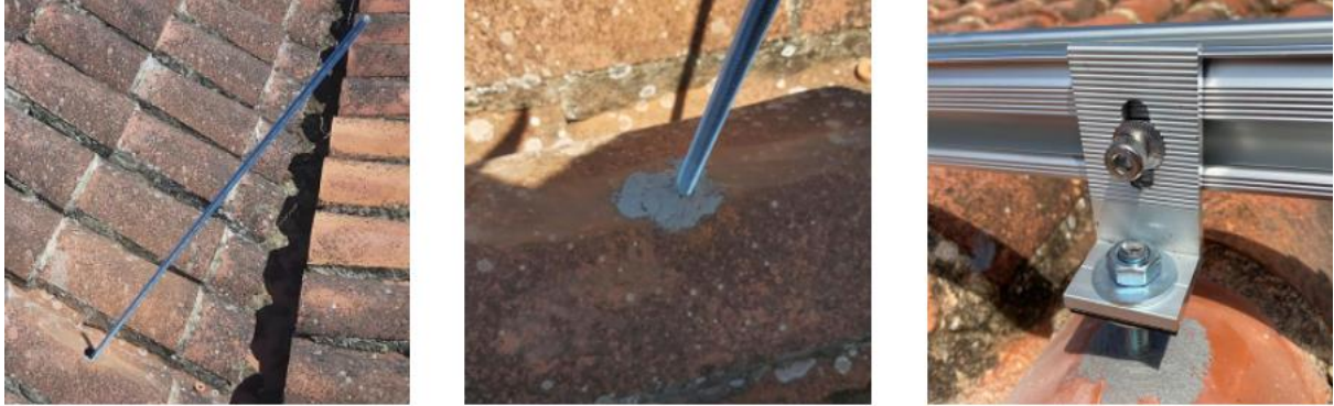
Figura 10 – Método de taladrado de la teja.
