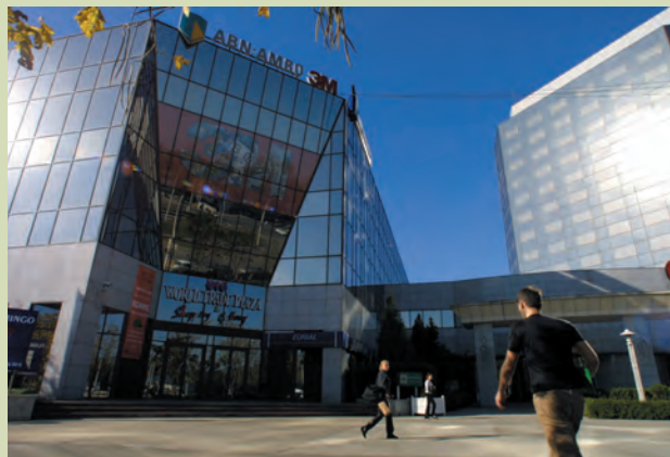
Edificio Plaza, en Bucarest
