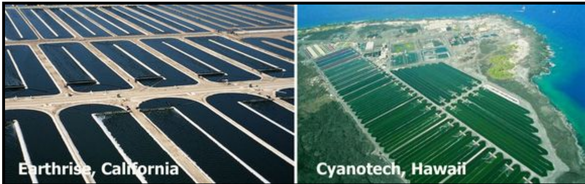
Imagen 5: Las dos empresas más importantes de producción de espirulina mediante sistemas de cultivo tipo raceways
