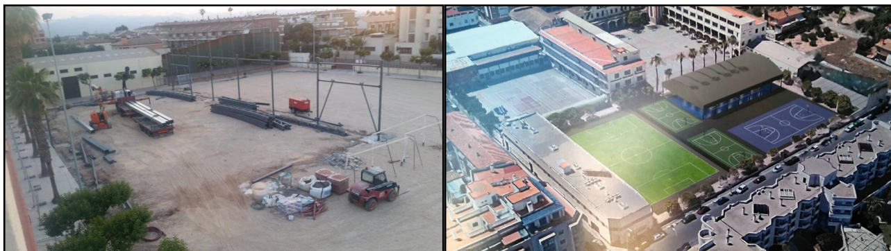
Figura 1. Zona 2 (durante de la reforma / después de la reforma)
