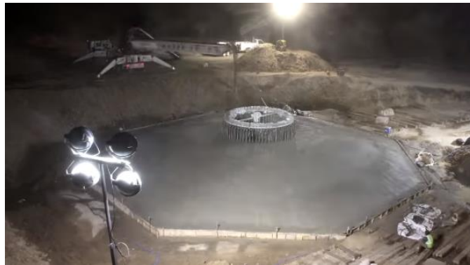
Figura 84 - Vertido del hormigón estructural de la cimentación. Fuente: Acciona.
