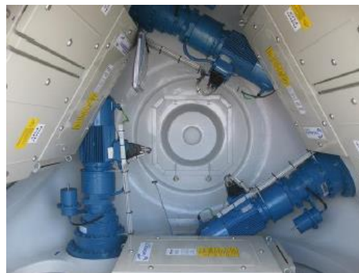
Figura 33 - Sistema de cambio del paso de pala.
