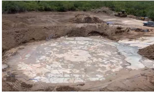
Figura 80 - Aplicación del hormigón de nivelación durante la construcción de la cimentación de los aerogeneradores. Fuente: Acciona.
