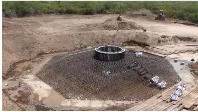
Figura 83 - Construcción de la jaula de pernos de la cimentación. Fuente: Acciona.
