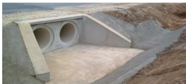
Figura 77 - Sistema de drenaje para viales. Fuente: Structuralia
