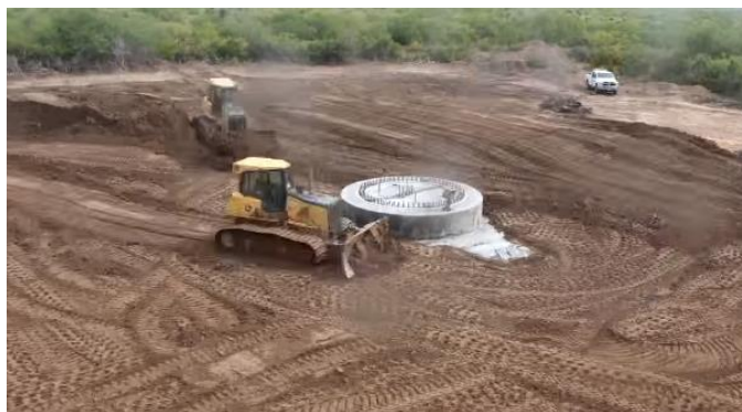
Figura 85 - Relleno de la superficie de la cimentación. Fuente: Acciona.
