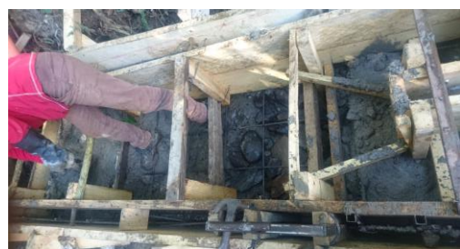
Imagen 2.11.- Encofrado de desarenador.
