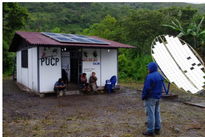
Imagen 2.1.- Instalación fotovoltaica Granja Ecológica.
