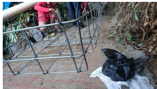
Imagen 2.9.- Armado de desarenador.
