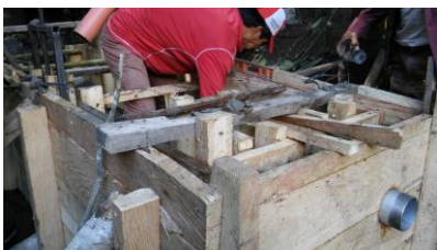
Imagen 2.10.- Encofrado de desarenador.
