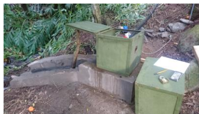
Imagen 2.15.- Caseta de la turbina
