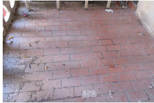
(Figura 27: Cubierta Patio de luces)
