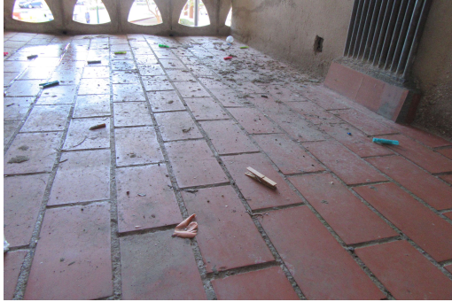
(Figura 26: Cubierta Patio de luces.)
