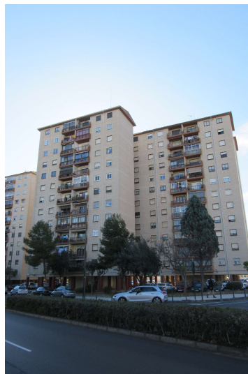
(Figura 9: Edificio Bloq 1 – Esc 1-2)
