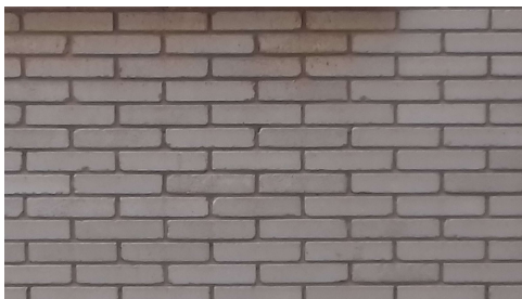
(Figura 27: fachada con aparejo a soga)
