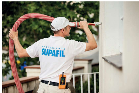
(Figura 36: Detalle sistema insuflado de lana mineral)
