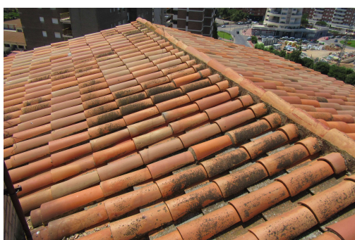
(Figura 21: Cubierta inclinada viviendas.)
