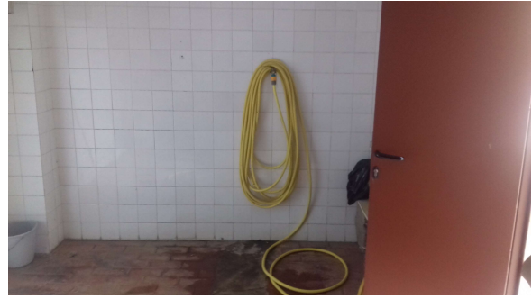
(Figura 33: Revestimiento cuarto limpieza.)
