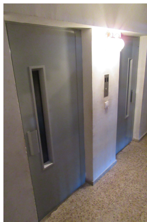
(Figura 19: Hueco ascensores)
