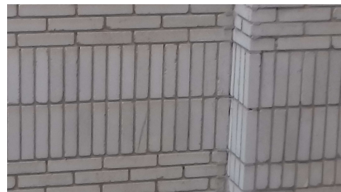
(Figura 28: fachada aparejo a doble sardinel.)
