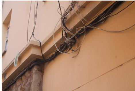
Figura 157. Imágen de instalación de telecomunicaciones y su mala conservación. Fuente: Elaboración propia.
