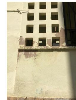
Figura 144, 145 y 146. Imágenes varias de fisuras y desprendimientos de l revestimiento continuo en fachadas
