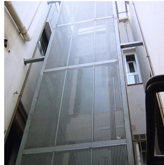
Figura 181. Imagen solución de instalación de ascensor por patio de luces.
