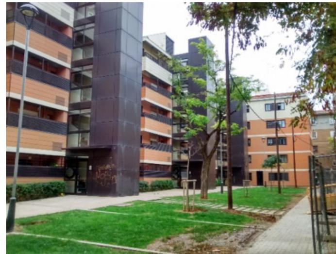
Figura 182. Imagen solución de instalación de ascensor por fachada exterior.
