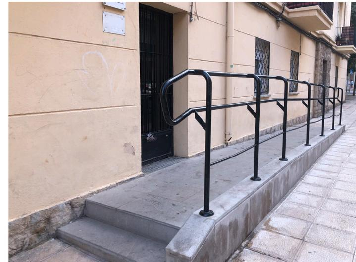
Figura 162 y 163. Accesibilidad a edificio mediante rampa/escalera. Fuente: Elaboración propia.
