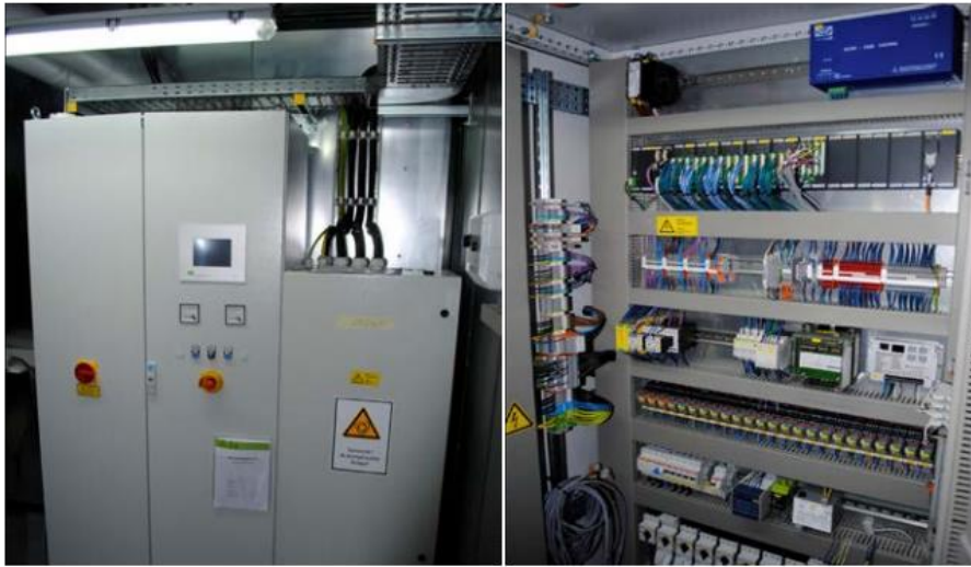
ILUSTRACIÓN A2.4: CUADRO DE CONTROLES ELÉCTRICOS
