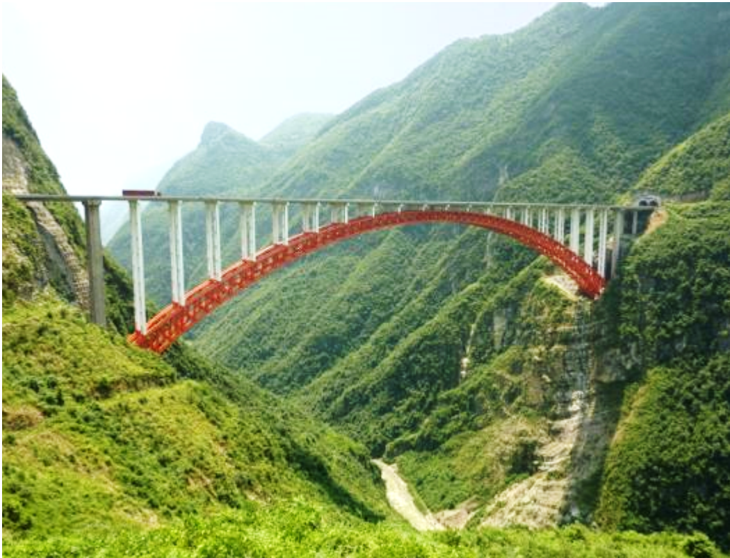
Figura 1. Puente del Zhijinghe [5].
