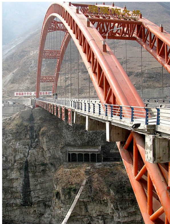
Figura 8. Puente con arco realizado con CFST [31].
