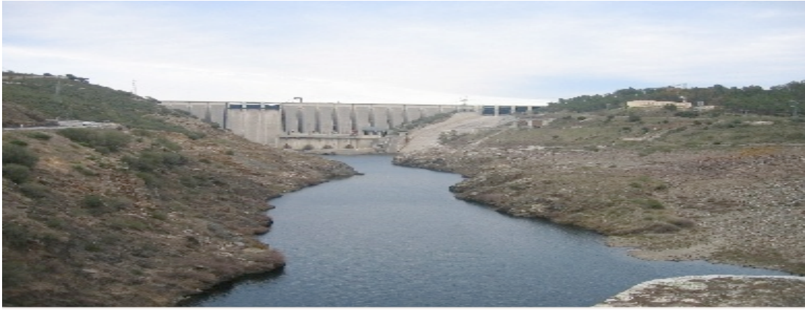
Imatge 62: Obra hidràulica
