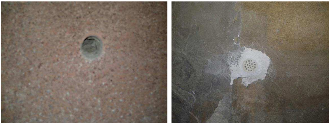
Figura 94: a) Perforación realizada en el muro; b) colocación de tapones cerámicos.
