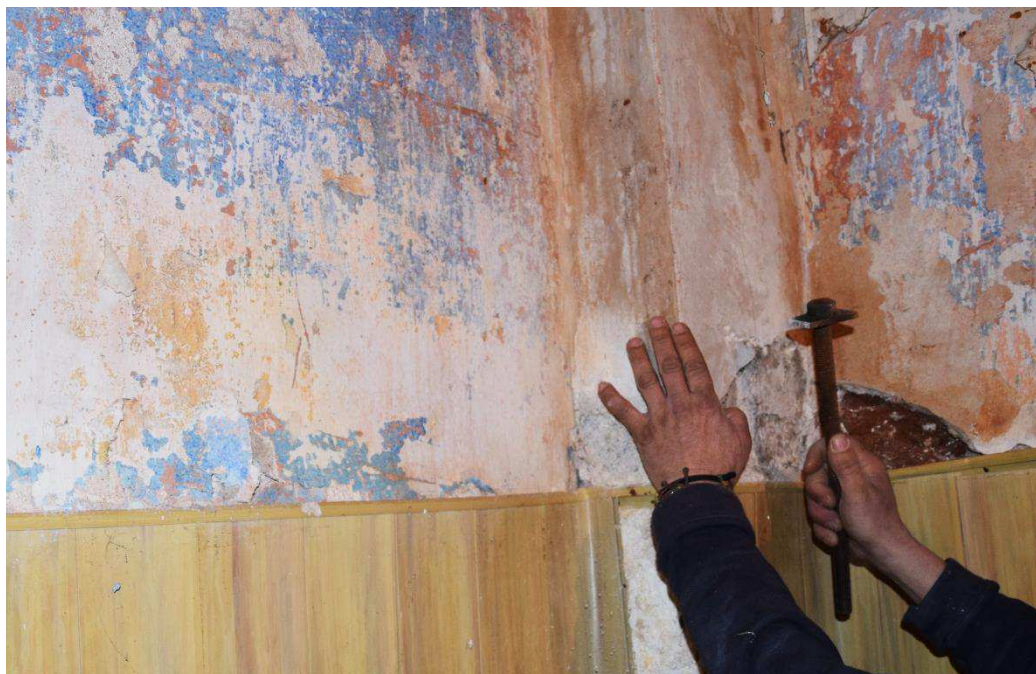
Figura 23: Retirada del recubrimiento de un pilar para poder llegar a analizar su interior.
