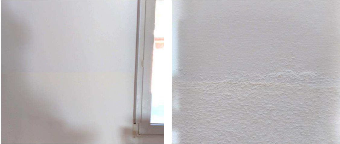
Fig.93. Superficie de acabado tras aplicar las pinturas, al silicato en la zona del mortero transpirable, y plástica sobre el revestimiento existente.
