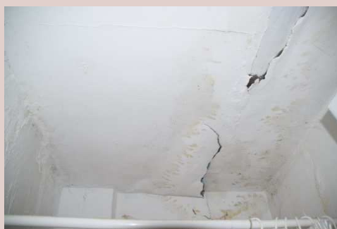
Figuras x y x: Desprendimientos y desconchados a causa de la humedad. Fuente propia.
