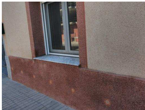
Figura 95: a) Pintura de los tapones cerámicos de color similar al monocapa; b) Vista general del muro de fachada terminado
