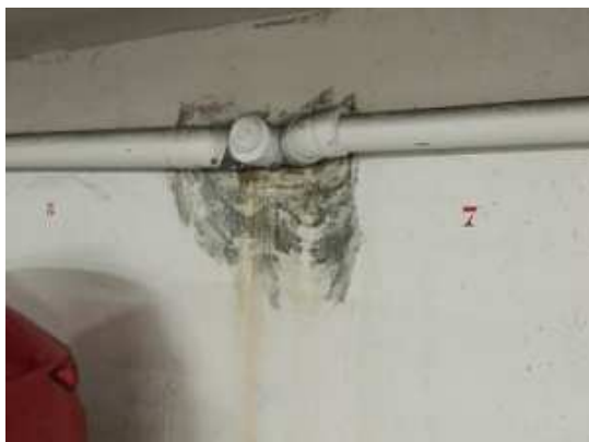
Figuras 4 y 5: Entrada de agua a través de los pasatubos. Fuente: HUME Ingeniería y Basementsystems.
