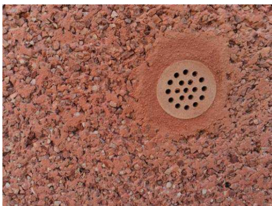
Figura 95: a) Pintura de los tapones cerámicos de color similar al monocapa; b) Vista general del muro de fachada terminado
