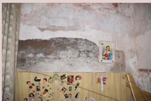
Figuras x y x: Desprendimientos y desconchados a causa de la humedad. Fuente propia.
