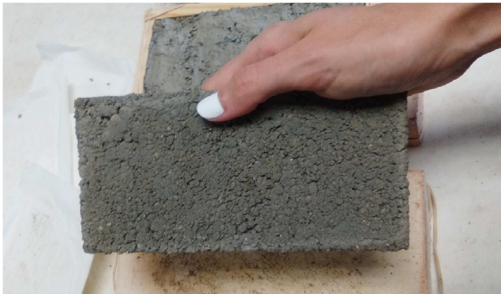
Figura 71: Mortero desprendido del ladrillo. Fuente propia.
