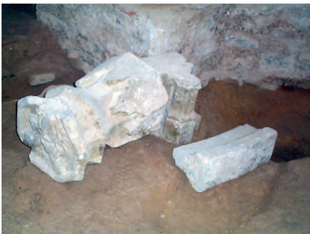
Figura 10. Conjunt de pedres treballades recuperades: clau de volta, dovella i arrencament d'arcada.
