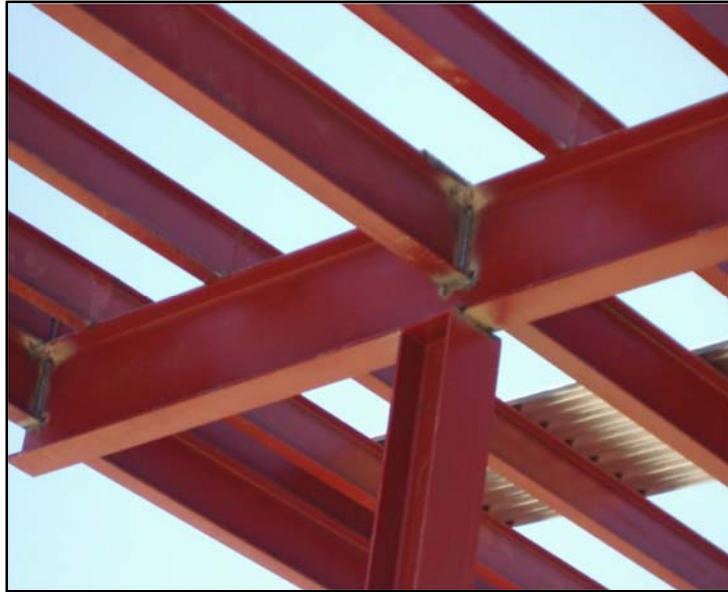
Figura 23: Unión mediante soldadura
