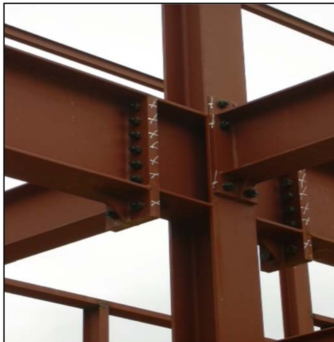
Figura 24: Unión mediante tornillos
