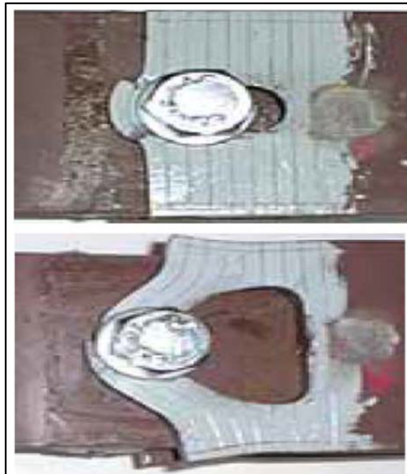
Figura 30: Modo de fallo por aplastamiento de la chapa
