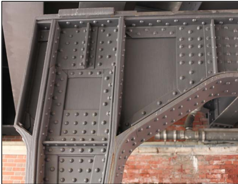
Figura 22: Unión mediante roblones
