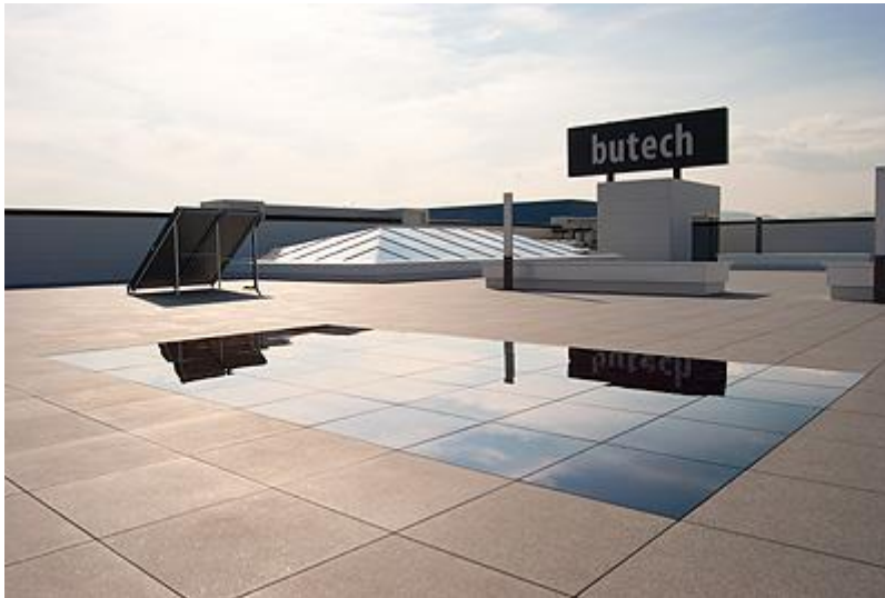
1.27 Azulejo fotovoltaico fabricado por Porcelanosa y Onyx solar y su posterior colocación.
