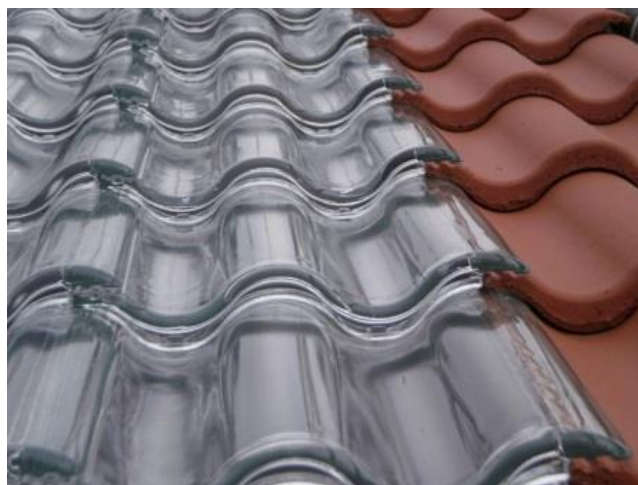
1.24 Tejas de cristal instaladas.
