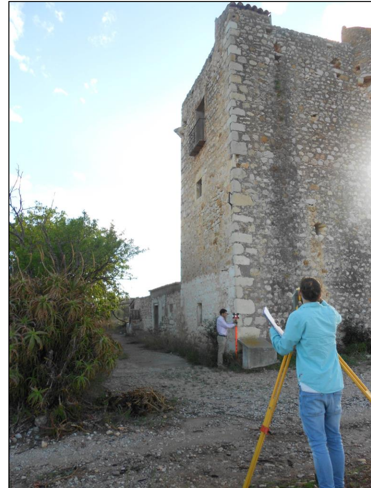
44. Fotografía de la realización de la toma de datos con estación total en Torre del Carmen. Fuente: R.Verdoy
