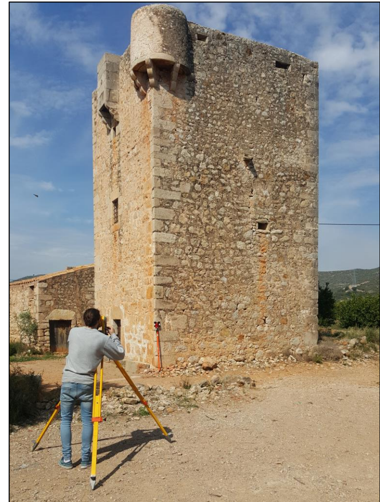
61. Toma de datos con la estación total de la Torre del Carmelet
