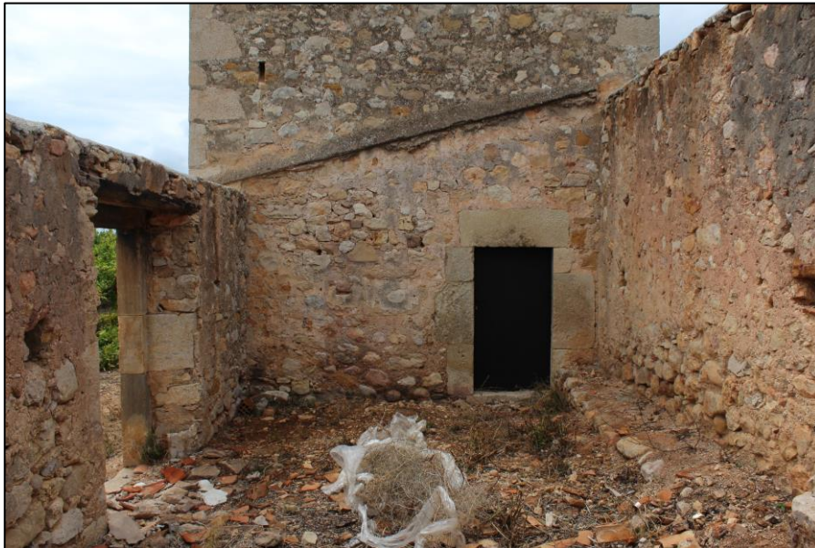
52. Fotografía de la Torre dels Gats. Se puede apreciar el acceso a la torre por el edificio adjunto, Así como el portal de entrada con remate de sillería.
