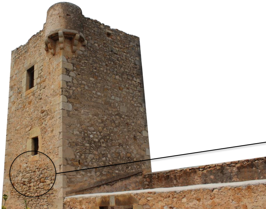
24. Fotografía de torre dels Gats. Fuente: R.Verdoy
