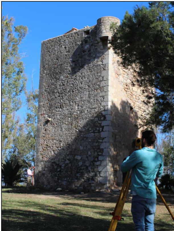
32. Fotografía de la toma de datos con estación total en Torre la Sal. Fuente:: R.Verdoy
