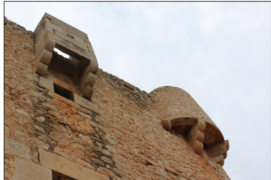
60. Fachada Sudeste donde se aprecian el matacán sobre la puerta de entrada y el garitón situado en la esquina derecha. Fuente: R.Verdoy
