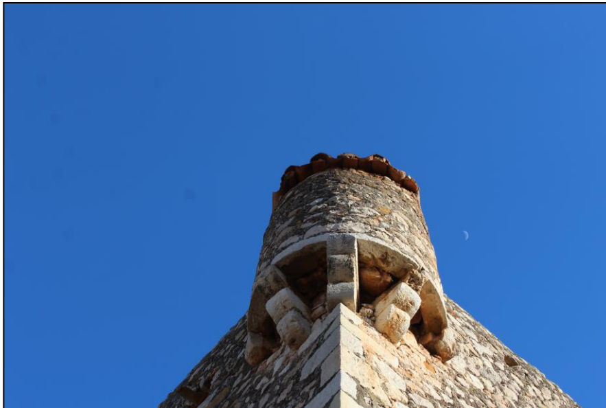
42. Gariton en buen estado de la Torre del Carmen, se aprecia también la sillería en la esquina de la construcción como material de refuerzo. Fuente: R.Verdoy
