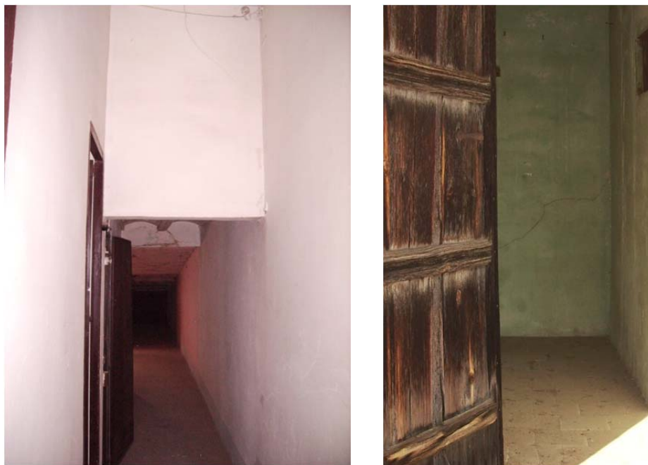
Figura 4.7.2.4. Revestimientos verticales planta tercera y bajo-cubierta
