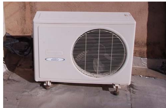
Figura 4.8.5.1. Unidad terminal exterior.
