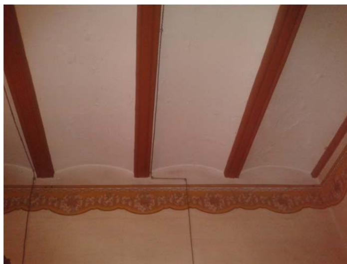
Figura 4.4.6.2. Forjado: Viguetas de madera y revoltón “VM_R”_1
