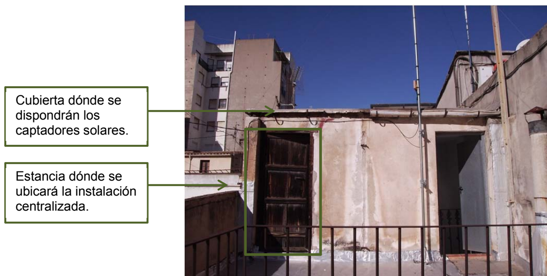
Figura 6.2.6.1. Disposición de la instalación solar térmica
