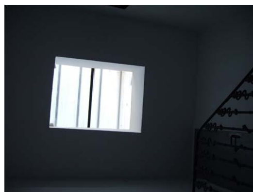
Falso techo ubicado en la cubierta de la caja de escalera.
