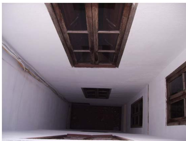
Figura 4.5.6.1. Carpintería de madera y vidrio simple
