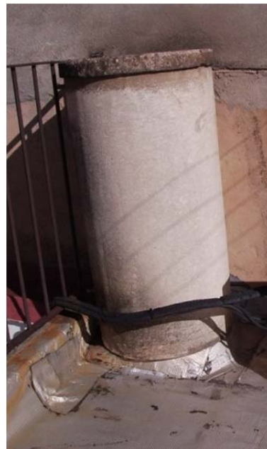
Figura 4.8.2.4. Depósito de fibrocemento.
