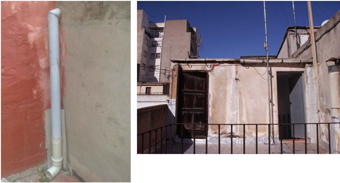
Figura 4.8.4.1. Evacuación de aguas pluviales.
