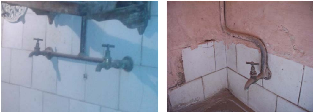
Figura 4.8.2.3. Derivaciones individuales.
