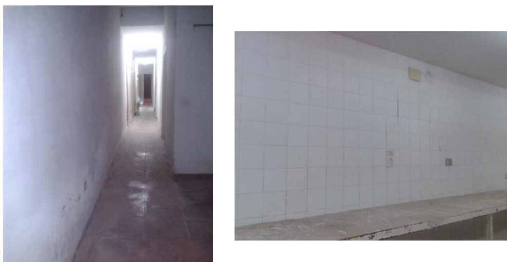
Figura 4.7.2.1. Revestimientos verticales planta baja
