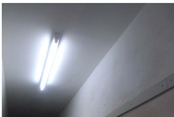
Falso techo ubicado en la planta baja
