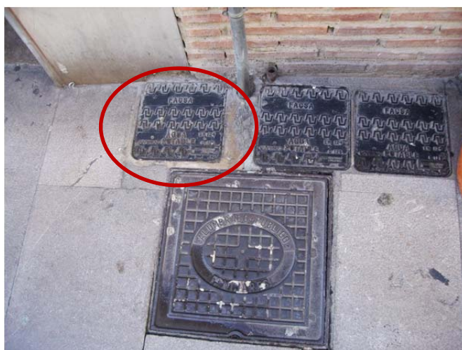
Figura 4.8.2.1. Acometida y contador.
