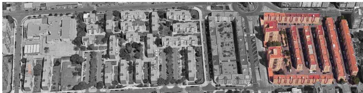
Fig. 70 Grupo 14 de junio dentro del conjunto residencial de vivienda social preconstitucional.
