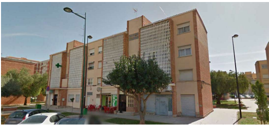
Fig. 78 Bloque de dos escalera.
