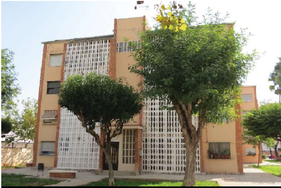
Fotografía de la fachada principal
