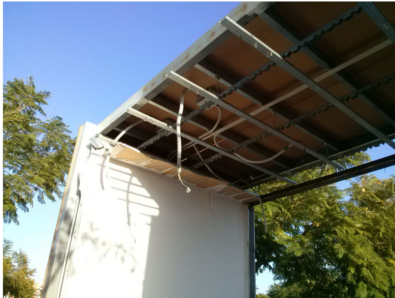
Foto 161. Estado del falso techo tras el desmontaje del éBRICKhouse 2014 / [EBH16]
