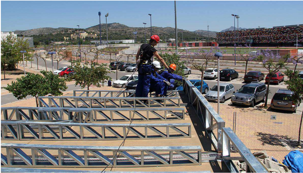
Foto 135. Emplazamiento de las cerchas sobre el forjado de techo / [EBH16]
