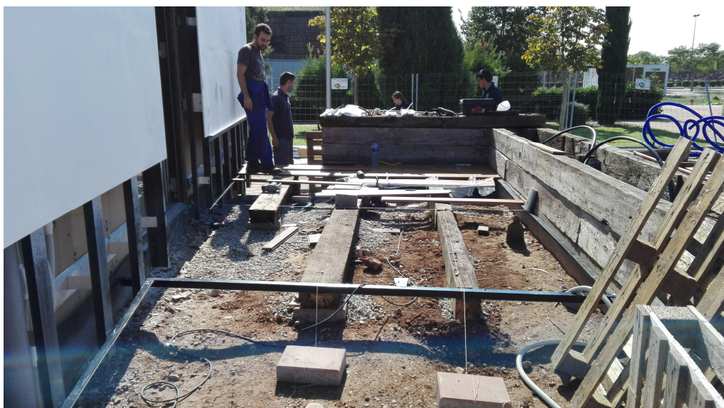
Foto 177. Colocación de los rastreles a la cota prevista / [EP]
