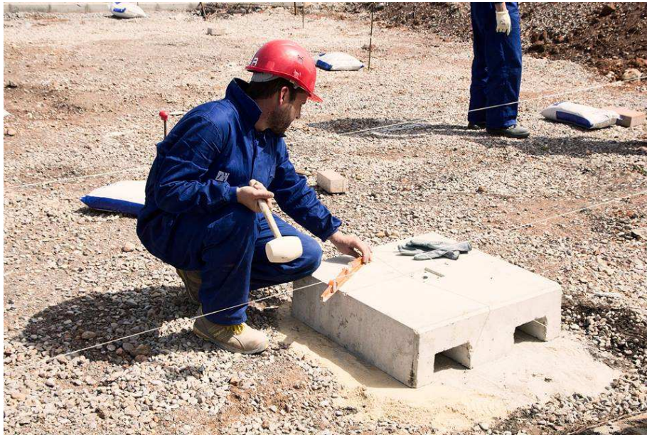
Foto 34. Nivelación de la zapata [EBH16]
