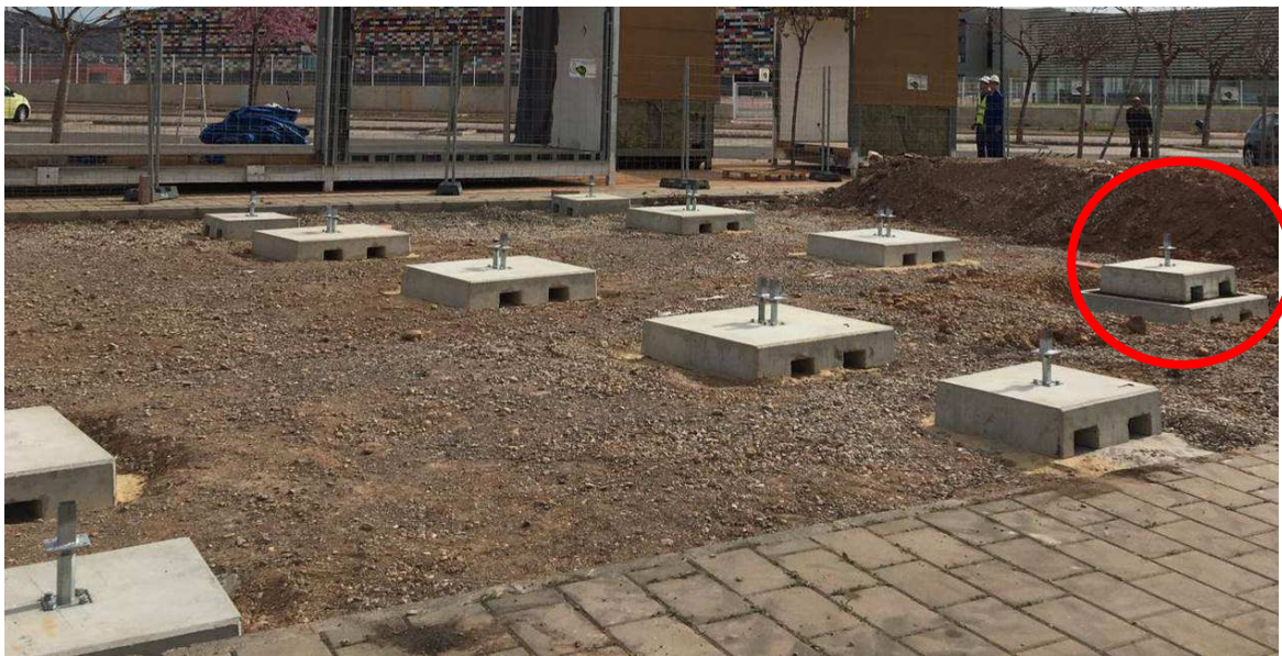
Foto 38. Pies regulables sobre cada zapata, con la altura deseada, preparados para recibir la estructura / [EBH16]
