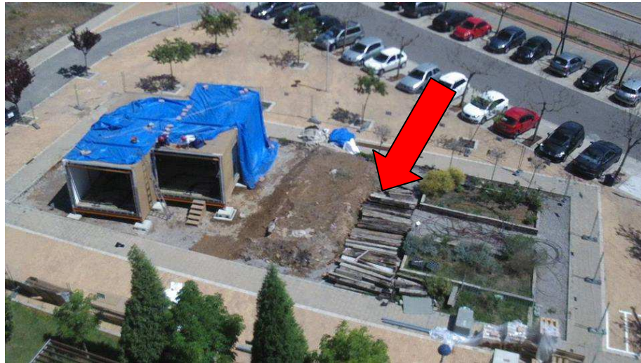
Foto 18. Localización de la zona de acopios de tierras y traviesas de las jardineras / [EBH16]
