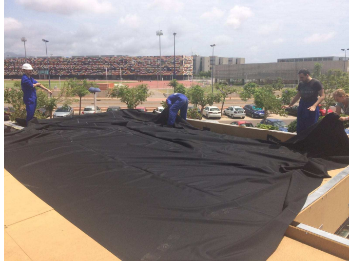
Foto 144. Extendido sobre uno de los faldones de una de las dos láminas fabricadas en taller / [EBH16]
