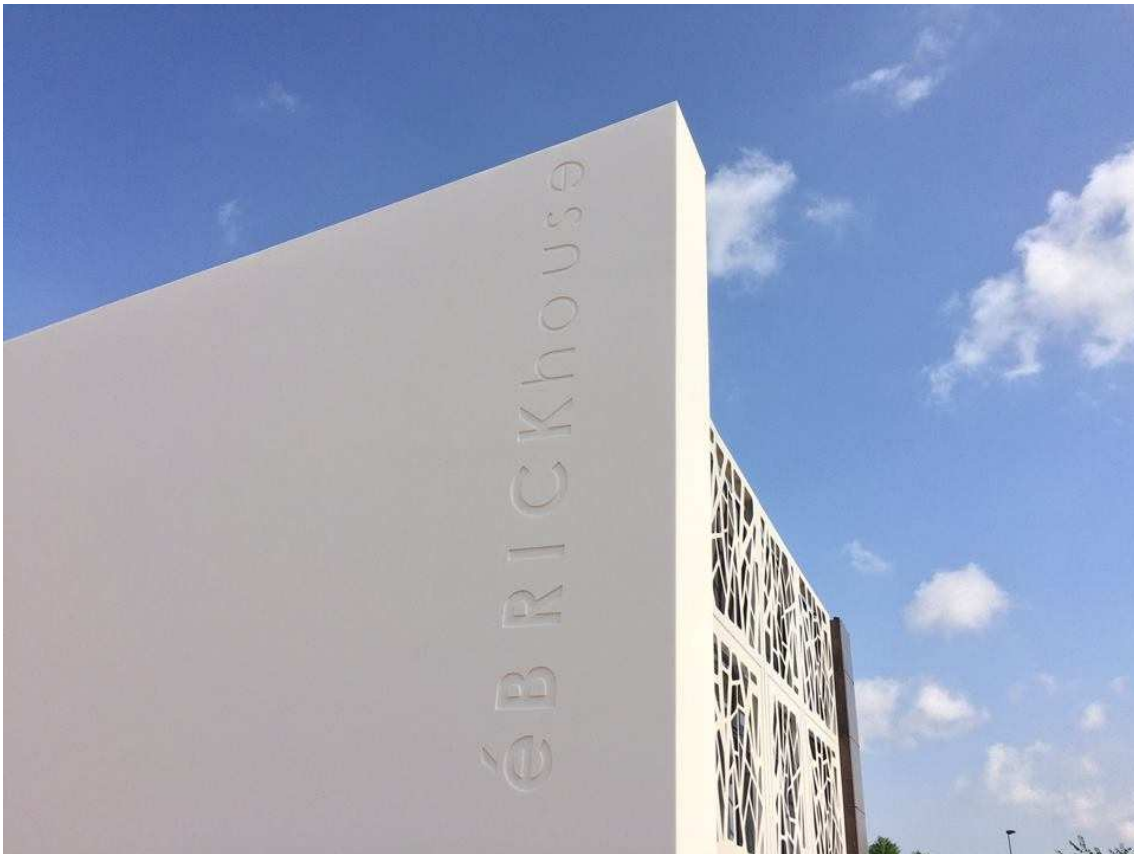
Foto 91. Fachada de Krion terminada / [EP]
