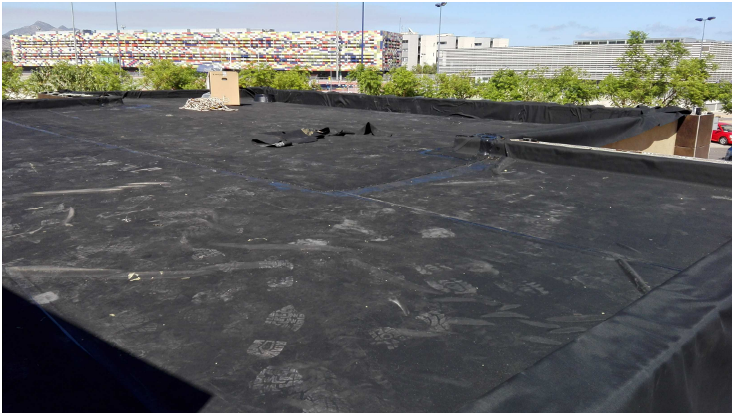
Foto 148. Cubrición e impermeabilización total de la cubierta / [EP]
