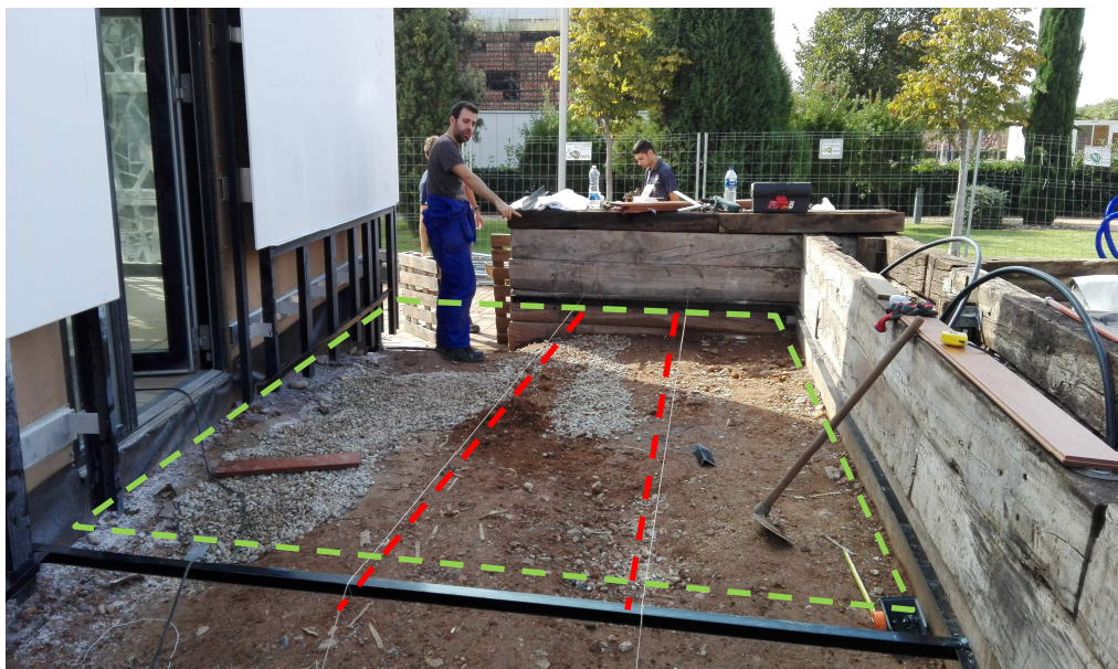
Foto 176. Replanteo del perímetro de la meseta y de nivel da la cara superior de los rastreles / [EP]
