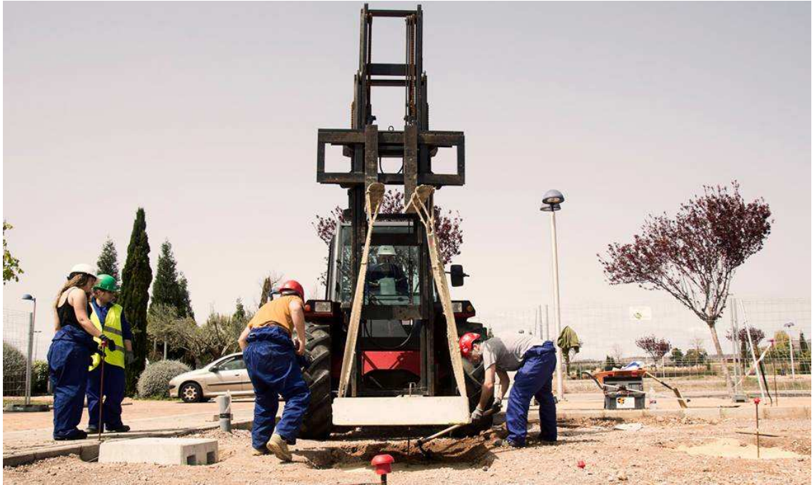
Foto 31. Traslado y descenso de cada zapata en su posición con ayuda de la carretilla elevadora / [EBH16]
