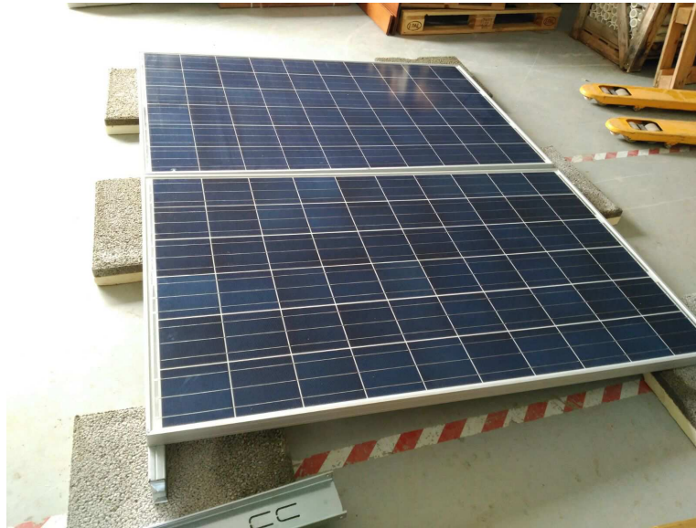
Foto 119. Replanteo de la solución de apoyo en el taller / [EBH16]
