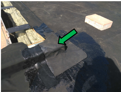
Foto 142. Refuerzo en esquinas / [EP]
