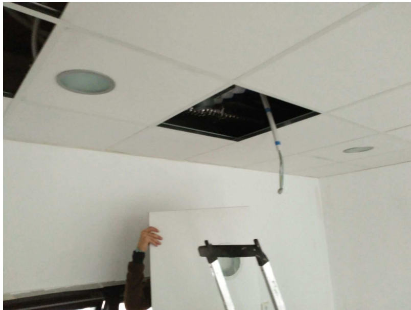
Foto 163. Instalación del falso techo desmontable / [EBH16]
