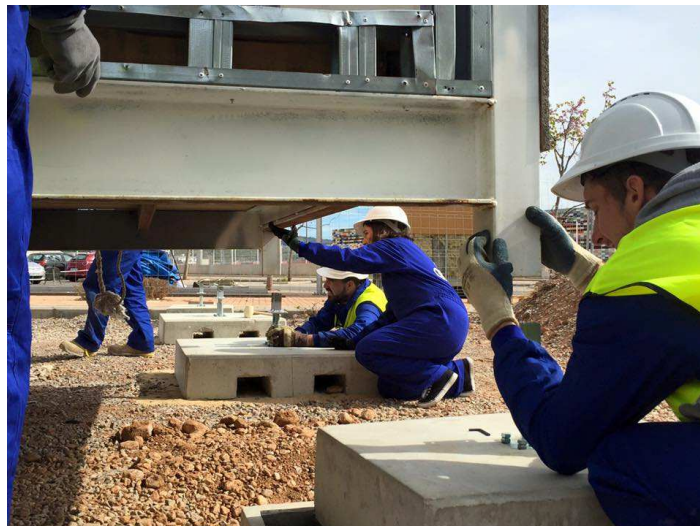
Foto 23. Encaje de la estructura sobre los pies derechos de la cimentación (Fase de Estructura)
