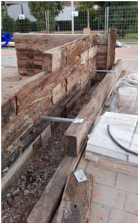
Foto 172. Cosido entre muros / [EP]
