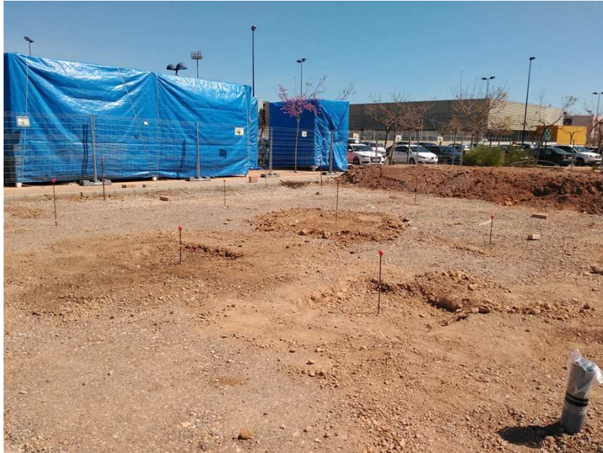
Foto 29. Excavación de la cimentación con las varillas todavía clavadas / [EBH16]
