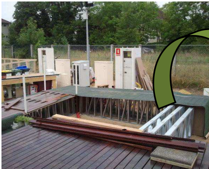
Foto 126. Steel frame en la rampa éBRICKhouse 2014 [equipe VIA-UJI]
