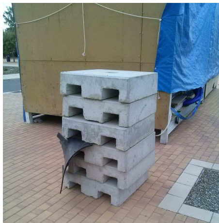
Foto 30. Acopio de las zapatas / [EP]
