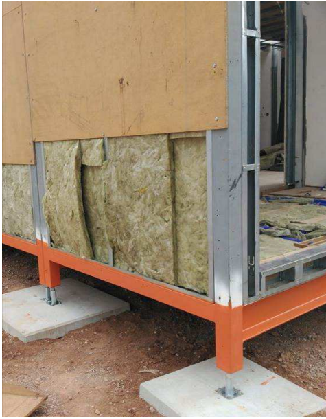
Foto 121. Aislante en paredes / [EP]
