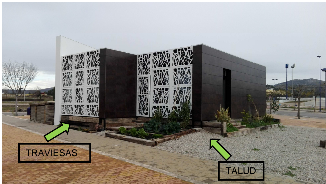
Foto 187. Zócalo en éBRICKhouse 2016 / [EBH16]
