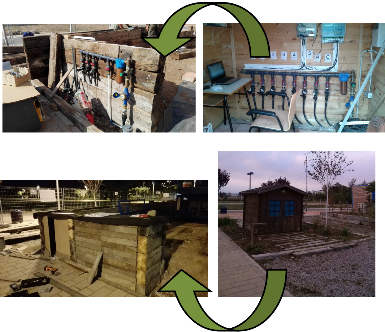
Imagen 43. Reubicación de la caseta de control del riego y sus instalaciones / [EP]
