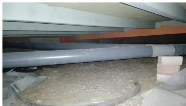
Foto 112. Ejecución de la red de saneamiento colgada bajo el forjado sanitario / [EP]
