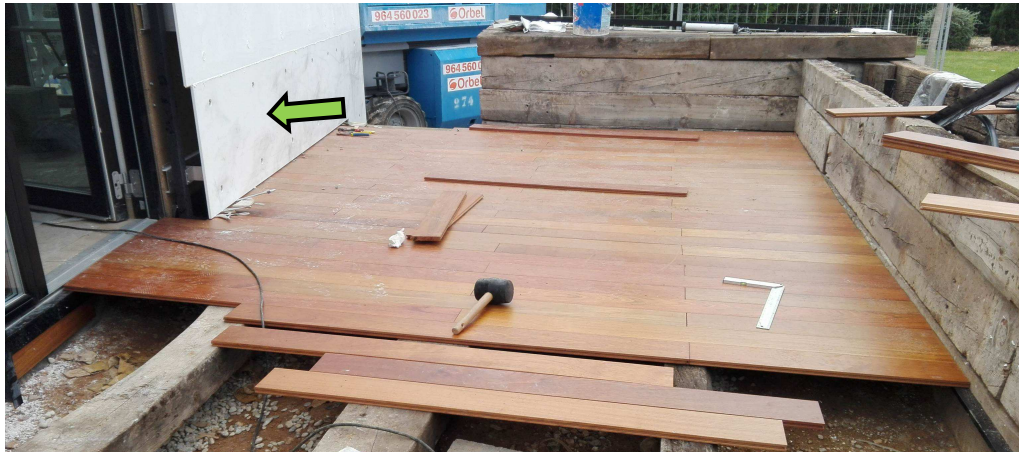
Foto 180. Necesaria coordinación entre el equipo de montaje del krion con el equipo de montaje de la rampa / [EP]
