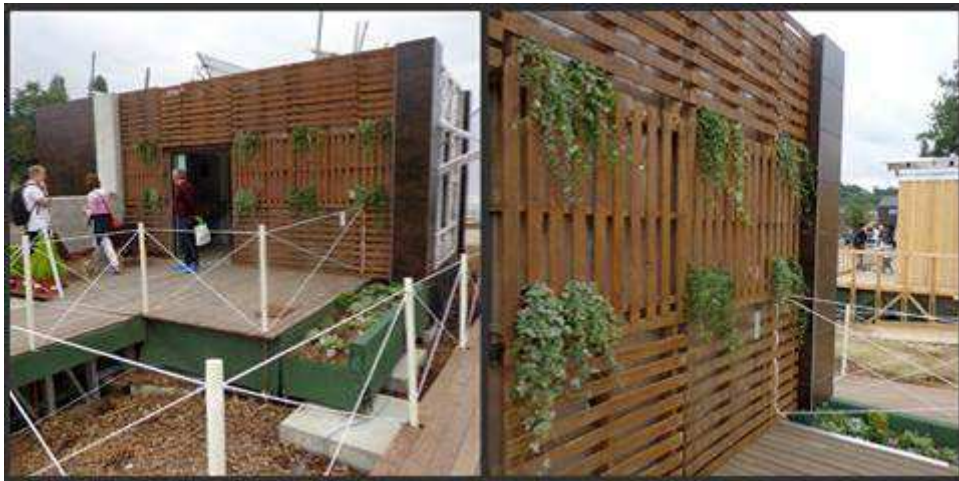
Imagen 24. Fachada oeste del prototipo / [equipe VIA-UJI]
