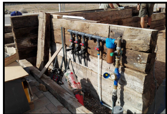
Caseta de instalaciones
