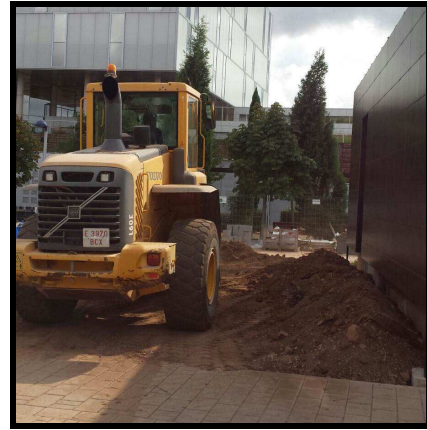
Taludes perimetrales de la vivienda
