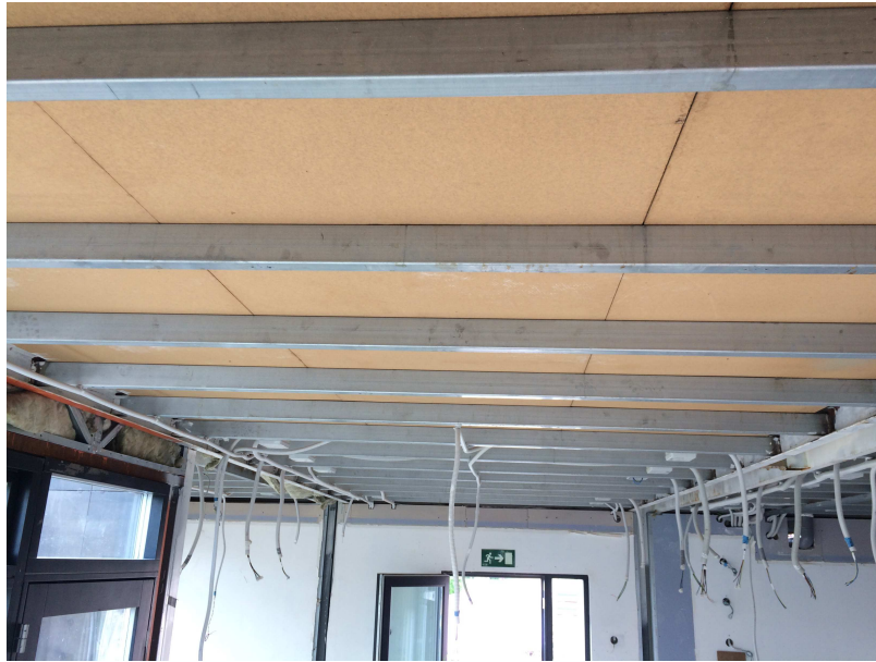
Foto 162. Eliminación de la perfilería del falso techo preexistente / EBH16]
