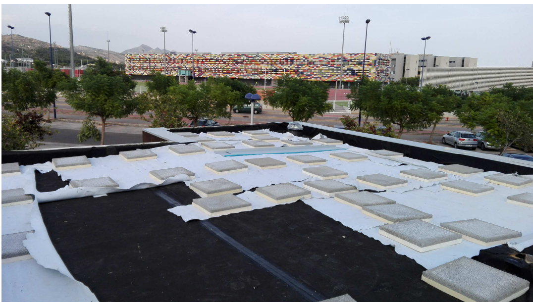
Foto 120. Disposición de los elementos de apoyo sobre la cubierta / [EP]
