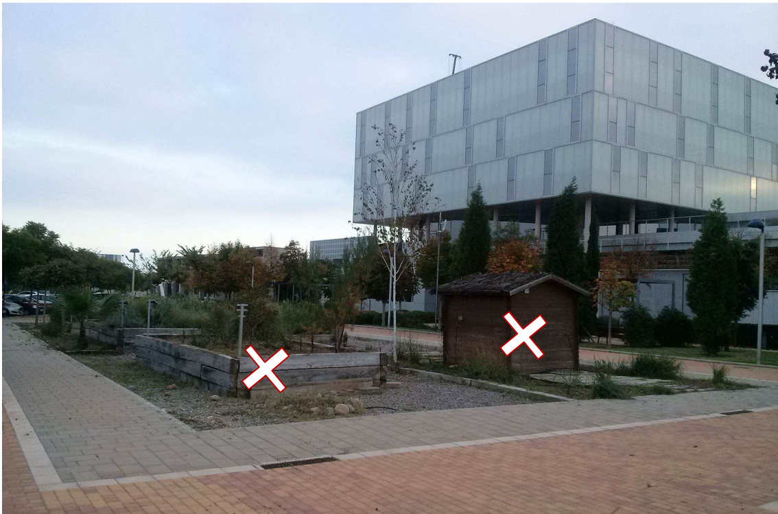
Foto 14. Jardinera y caseta prefabricada de riego a retirar / [fuente: Elaboración Propia (EP)]
