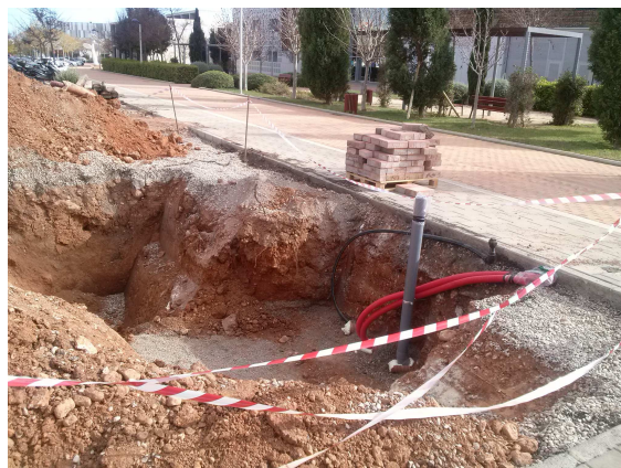
Foto 19. Localización de acometidas. [éBRICKhouse 2016]
