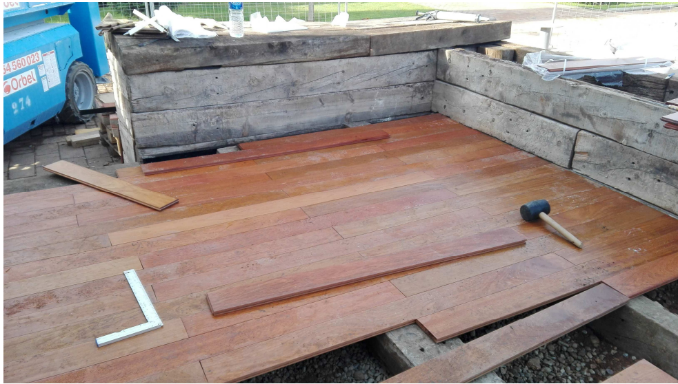
Foto 178. Colocación de las tablas a junta trabada / [EP]
