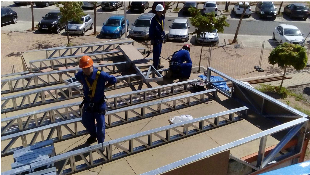
Foto 134. Emplazamiento de las cerchas sobre el forjado de techo / [EBH16]
