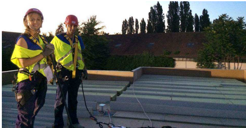
Foto 125. Cubierta éBRICKhouse 2014 / [equipe VIA-UJI]
