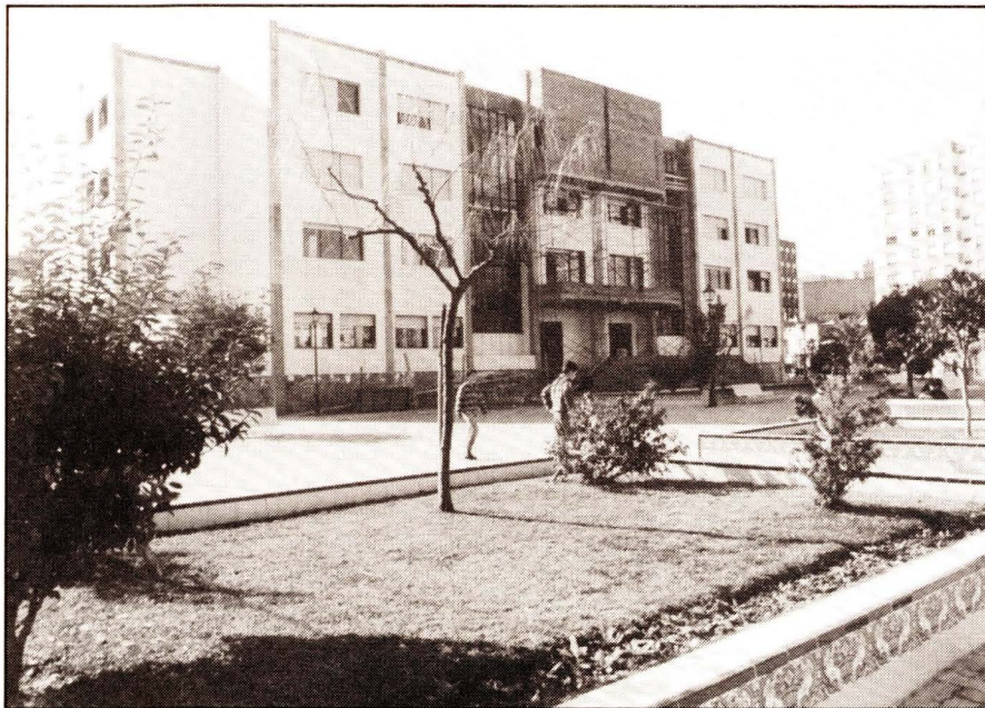
Las obras de la nueva Escuela de Idiomas se encuentran en su última fase. Están situadas en la nueva plaza de Las Columbretes, en el solar de la antigua Prisión Provincial.
