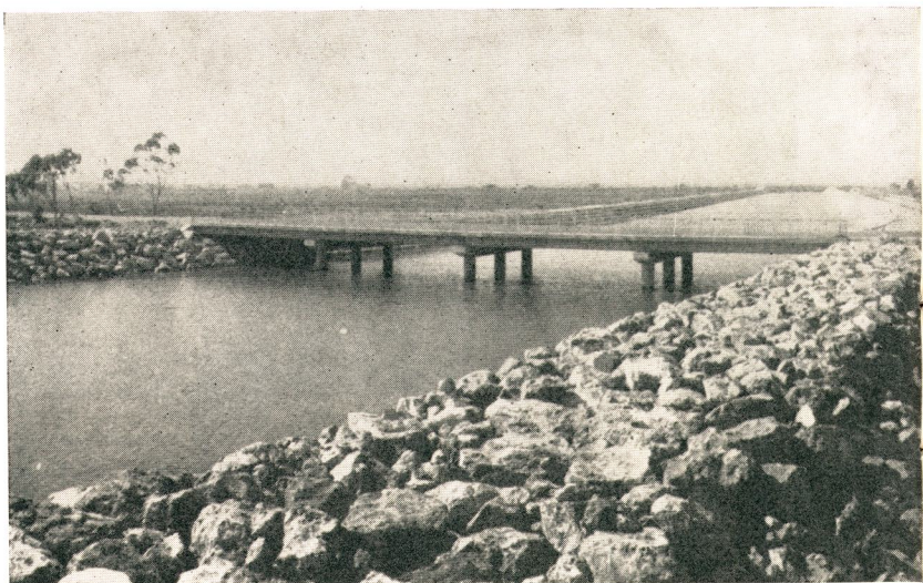
Nuevo puente sobre el cauce ampliado del río Seco
