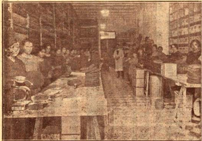
Una vista parcial del interior de la Fábrica
