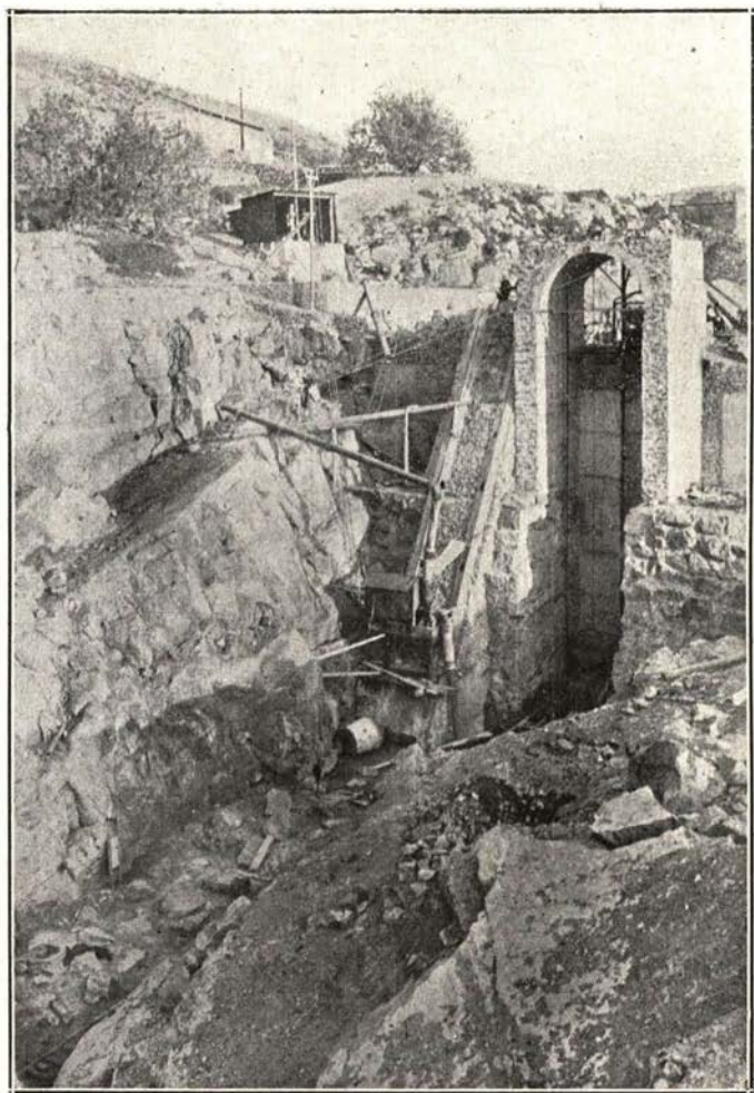
Ascensor para la extracción de materiales y construcción de la fundación de la presa
