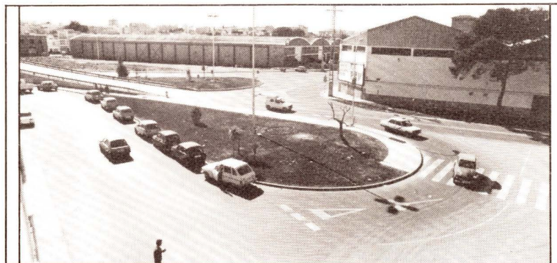
Nuevos accesos al paso elevado sobre la vía férrea en la Avenida de Benicàsim.
