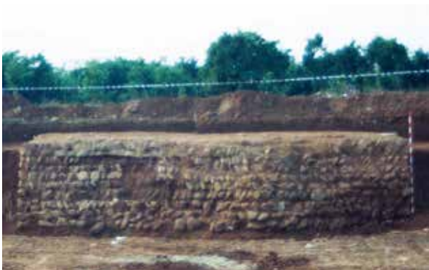
Figura 4. Vista frontal de la estructura.
