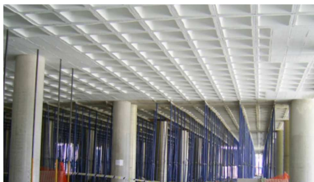
Fotografía 30. Pintura ablativa aplicada
