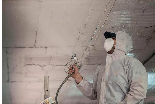
Fotografía 31. Aplicación de mortero de yeso
