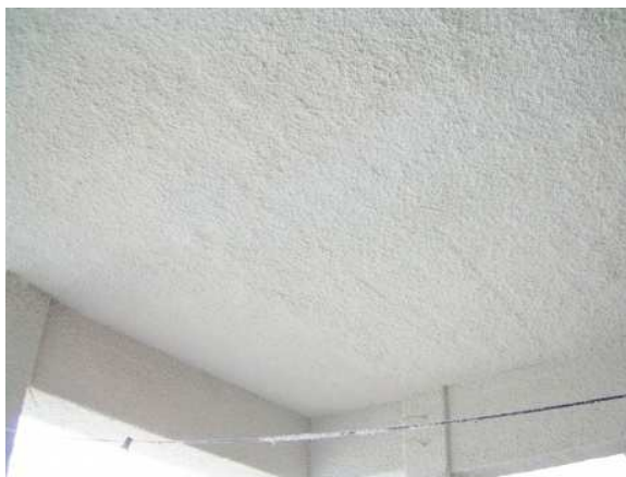
Fotografía 30. Mortero ignífugo aplicado
