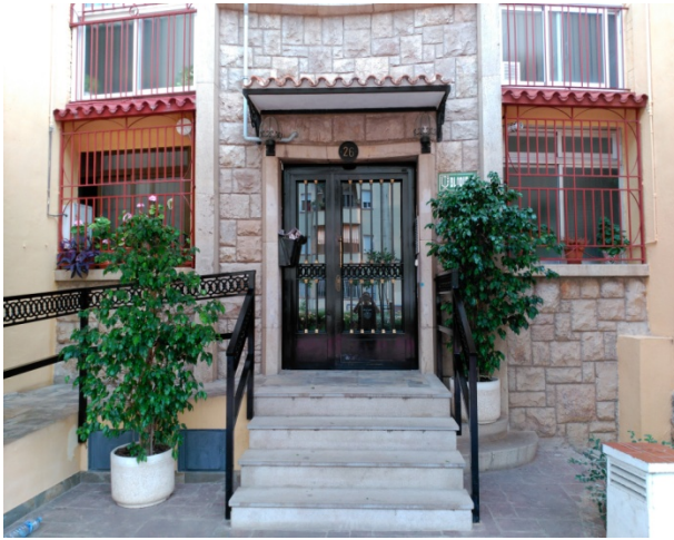
Imagen 28. Acceso al edificio.
