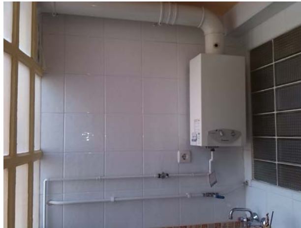
Imagen 52. Revestimiento cerámico en galería reformada.
