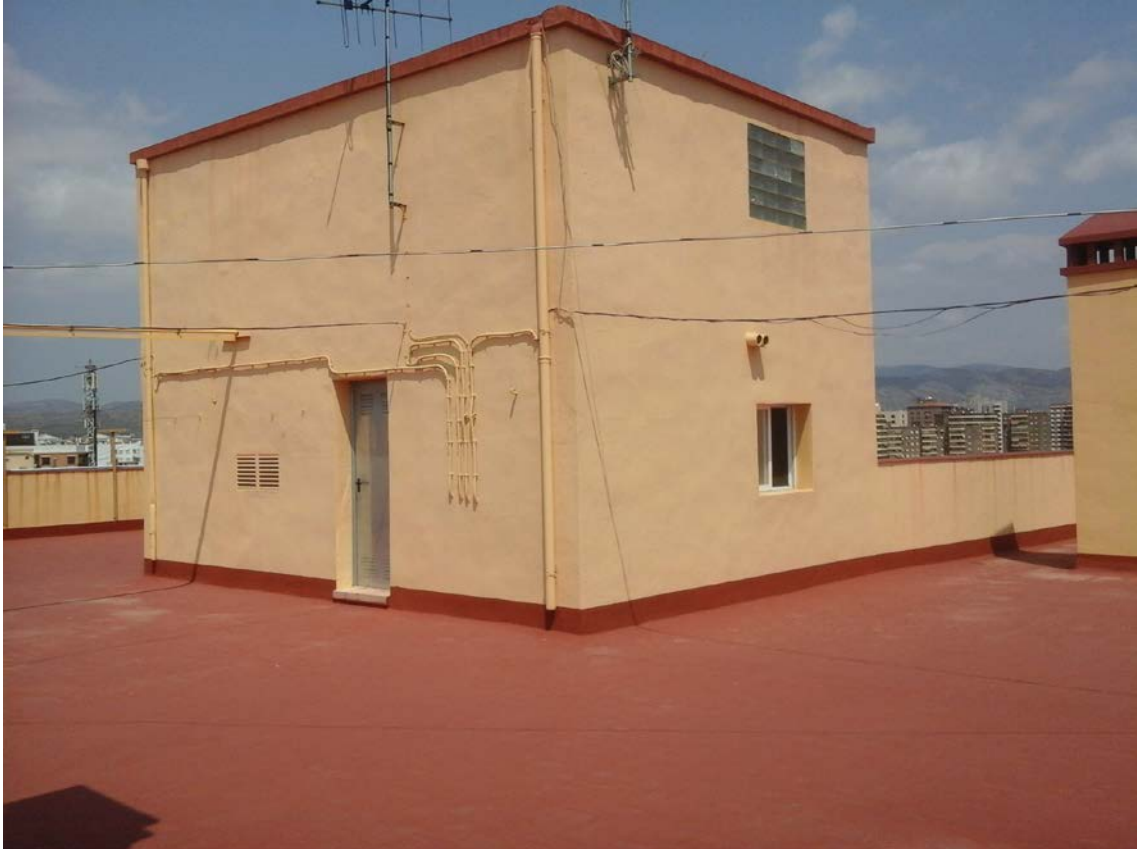
Imagen 48. Cubierta del edificio..
