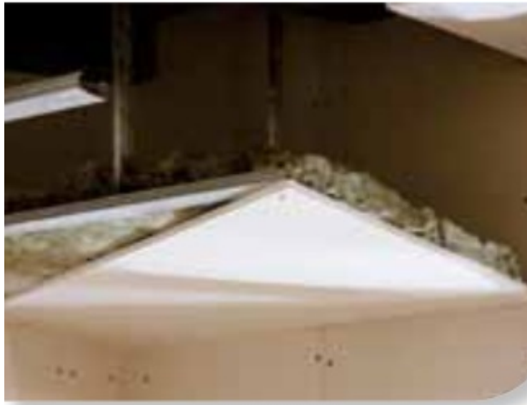
Imagen 61. Placa de yeso laminada con aislamiento térmico en rehabilitación desde el interior.
