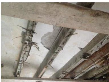
**\*Detalle viguetas forjado cubierta**
