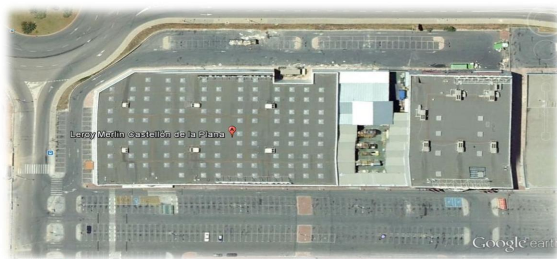
Ilustración I. Vista aérea nave Leroy Merlín.
