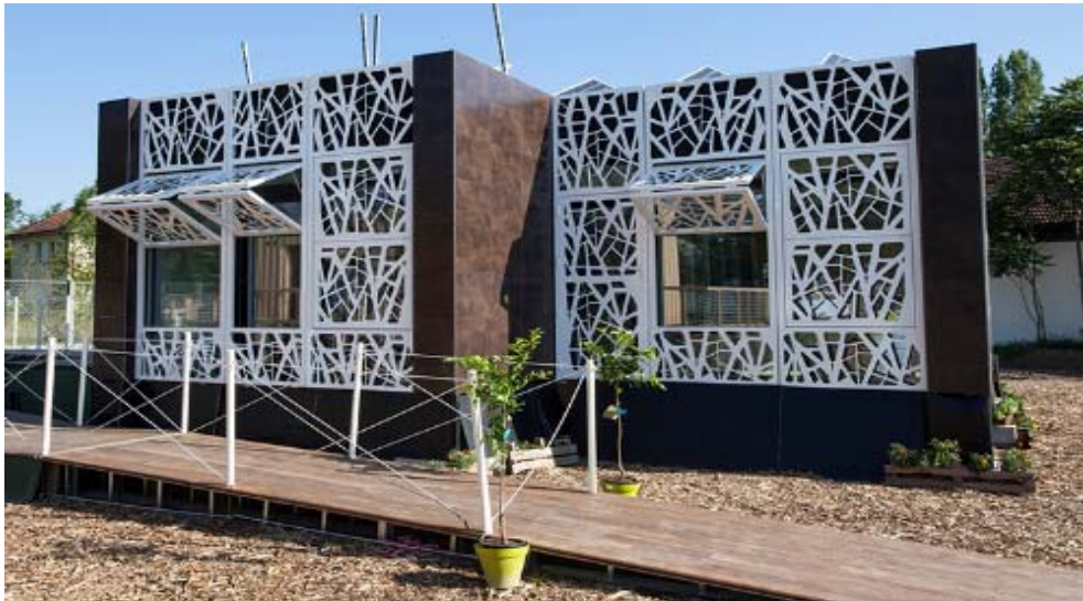
Imagen-1.Imagen del proyecto éBRICKhouse 2014 construido en Versailles.
