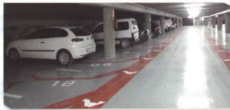
Sobri al públic el pàrquing del passeig marítim
