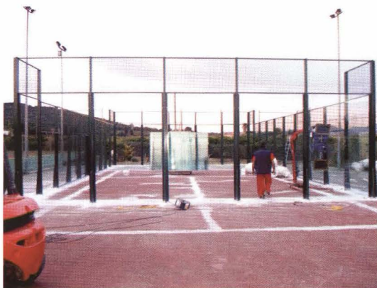
El nuevo pádel de cristal está ya terminado
