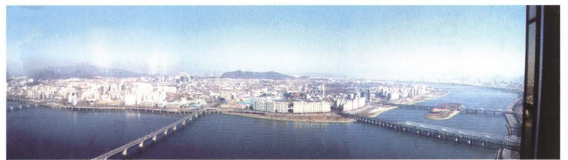
Panoràmica d'una part de Seül vista des de l'edifici 63
