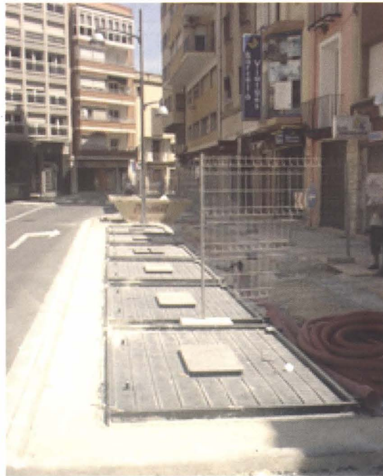
Vista de la obra de los nuevos contenedores subterráneos de la calle San Francisco
