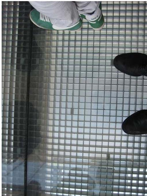
*Figura 12: Rejilla electrosoldada que sirve para el paso de personas*
