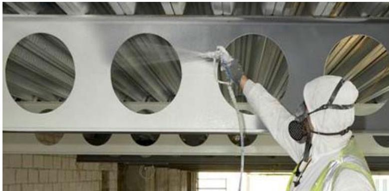
*Figura 42: Viga pintada con pintura intumescente*
